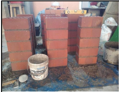
Asentado de pilas de ladrillo
