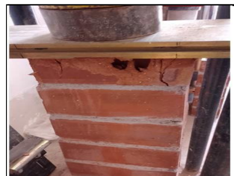
Ensayo de compresión en pilas de albañilería
