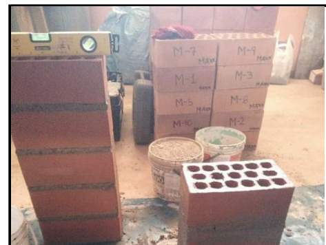
Asentado de pilas de albañilería
