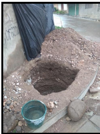
Figura 37. Excavación del hueco
