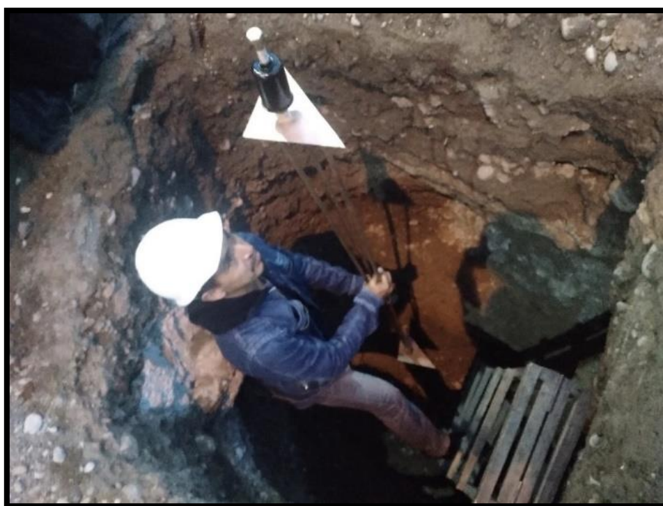
Figura 39. Introducción el nuevo diseño de varilla de cobre al pozo
