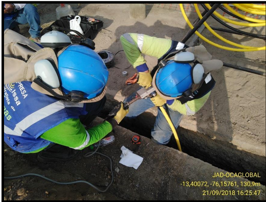
Imagen 46: Termofusión a socket de tubería de 25 mm. Fuente: Fotografía propia
