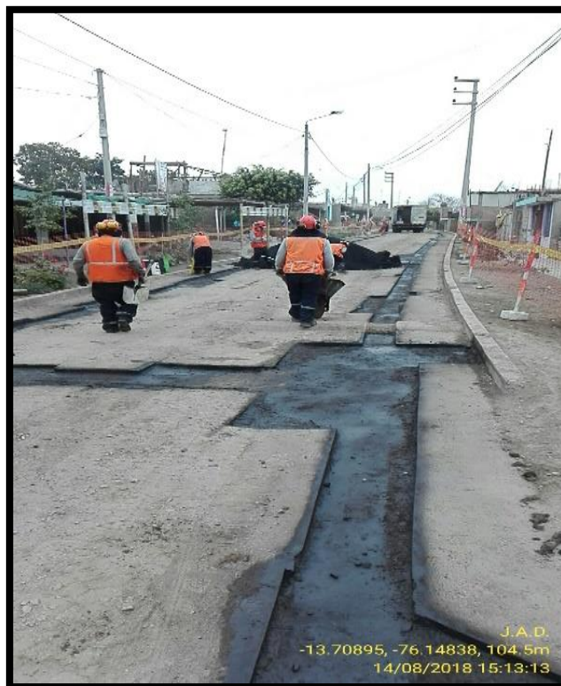
Imagen 26: Imprimación de tramos a reponer Fuente: Fotografía propia
