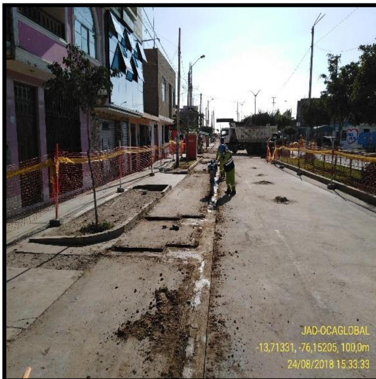
Imagen 21: Compactación de la base Fuente: Fotografía propia
