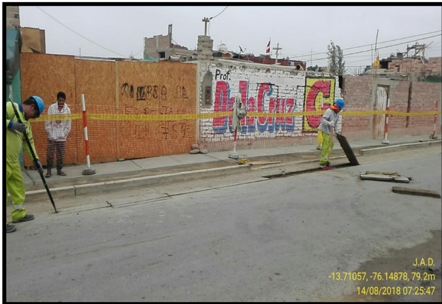
Imagen 38: Extracción manual de pavimento cortado Fuente: Fotografía propia
