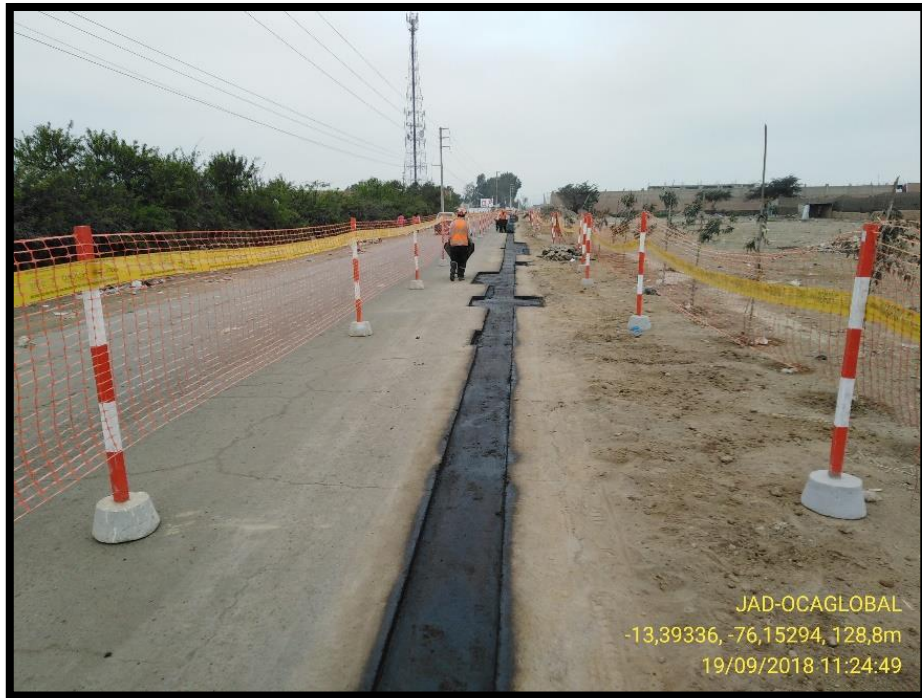
Imagen 55: Tramo imprimado con emulsión asfáltica Fuente: Fotografía propia
