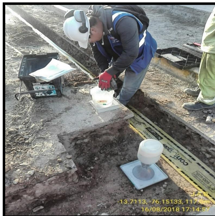
Imagen 52: Ensayo de densidad de campo de la subbase Fuente: Fotografía propia
