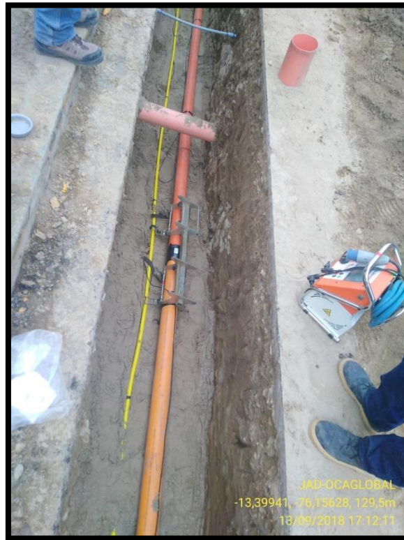
Imagen 17: Electrofusión de tubería de polietileno de 110 mm. con accesorios tipo unión
