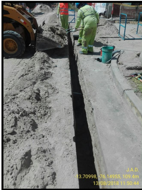
Imagen 18: Instalación de cama de arena superior
