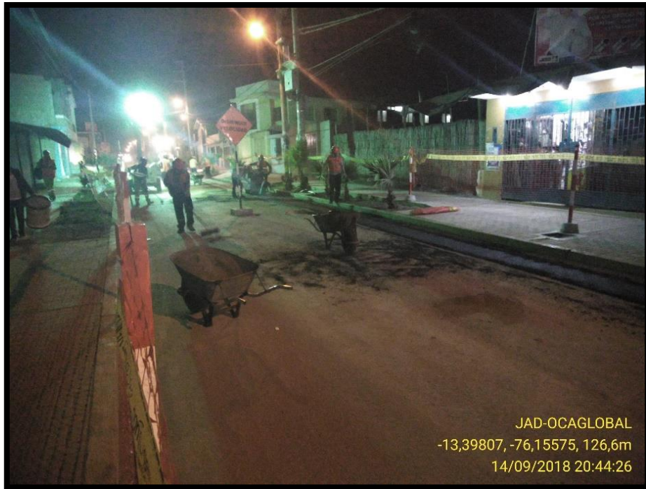
Imagen 57: Trabajos de reposición de asfalto nocturnos Fuente: Fotografía propia
