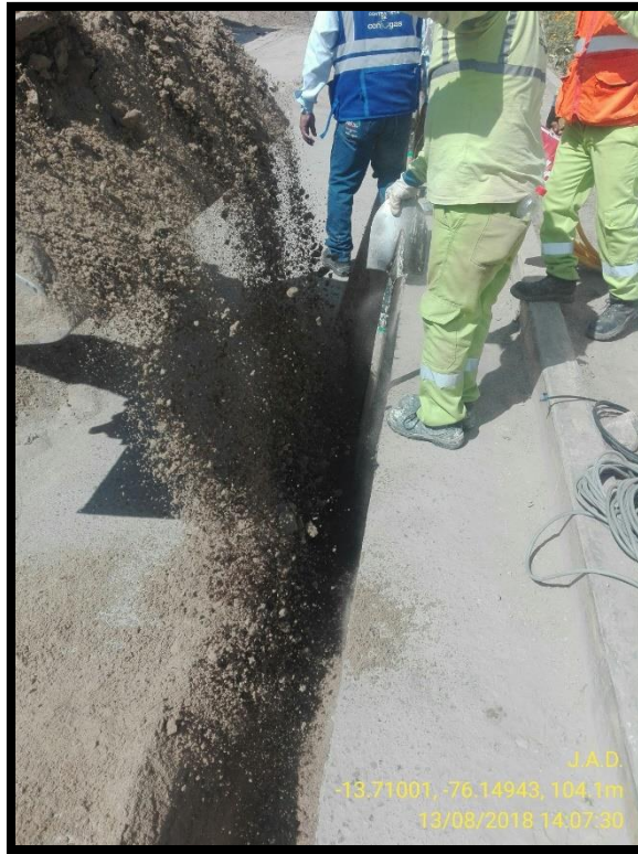
Imagen 19: Relleno de zanja con material de préstamo
