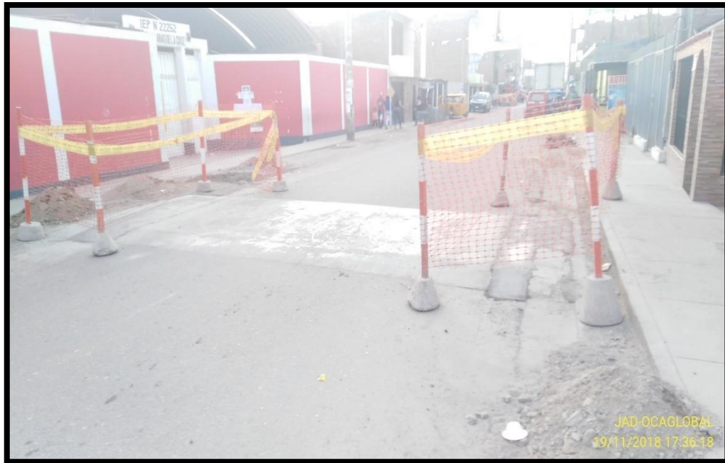
Imagen 27: Reposición de gibas de concreto Fuente: Fotografía propia
