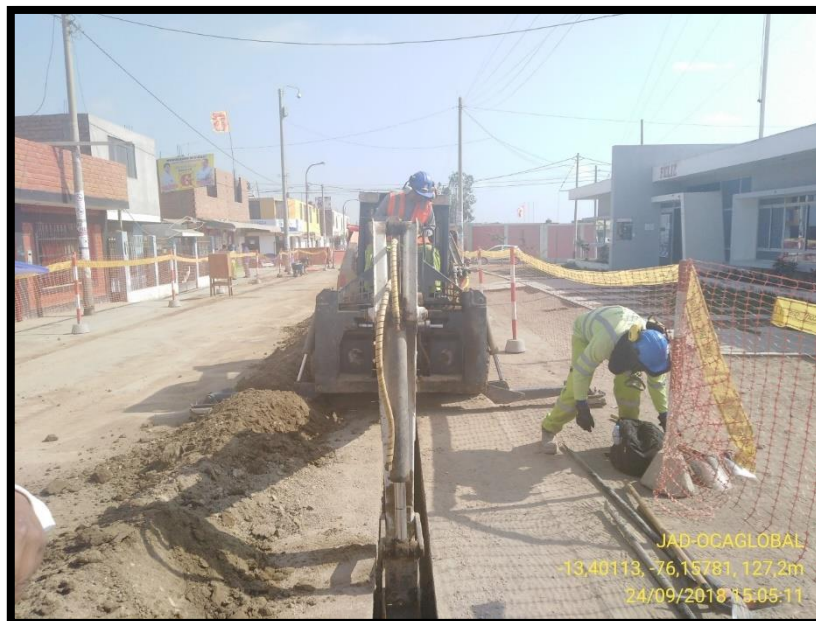
Imagen 41: Excavación mecánica con mini cargador Fuente: Fotografía propia
