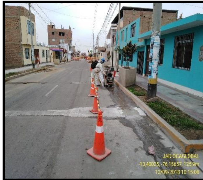
Imagen 36: Demolición de pavimento flexible con cortadora de cuerpo completo Fuente: Fotografía propia
