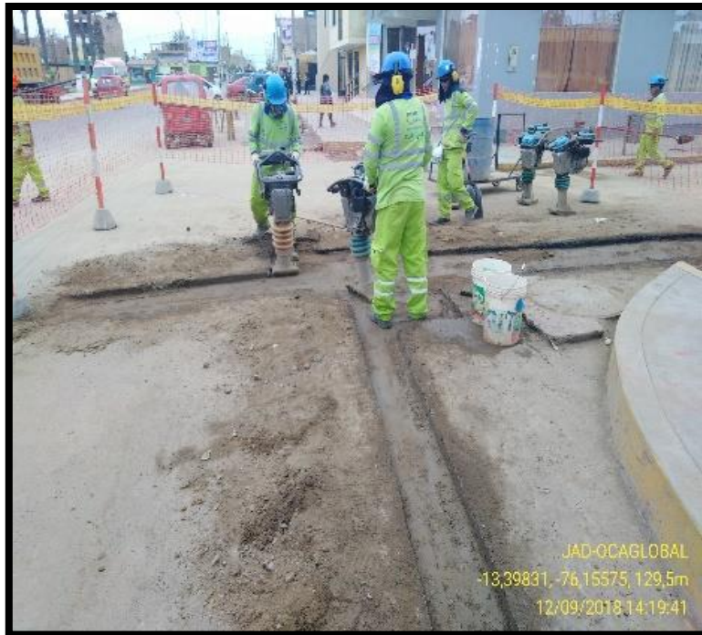
Imagen 51: Compactación de la base Fuente: Fotografía propia
