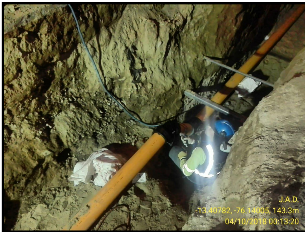
Imagen 16: Electrofusión de tubería de 110 mm. de polietileno con accesorios tipo codo 45°
