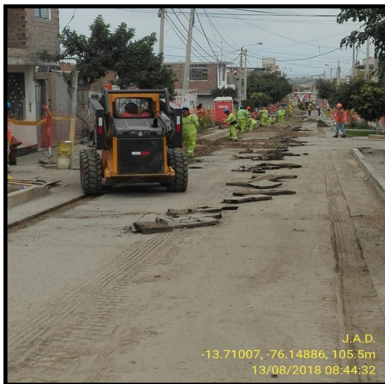
Imagen 10: Tramo cortado con cortadora de cuerpo completo y demolido con punta de minicargador
