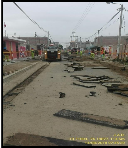
Imagen 37: Demolición de pavimento flexible con punta en mini cargador Fuente: Fotografía propia
