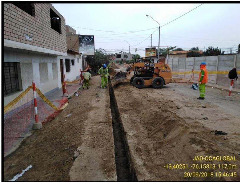
Imagen 42: Relleno de cama de arena inferior Fuente: Fotografía propia
