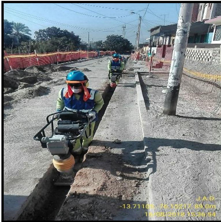
Imagen 20: Compactación de la sub-base Fuente: Fotografía propia
