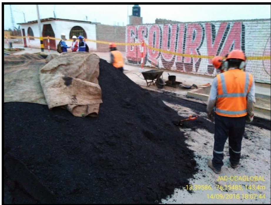
Imagen 56: Acopio de asfalto Fuente: Fotografía propia
