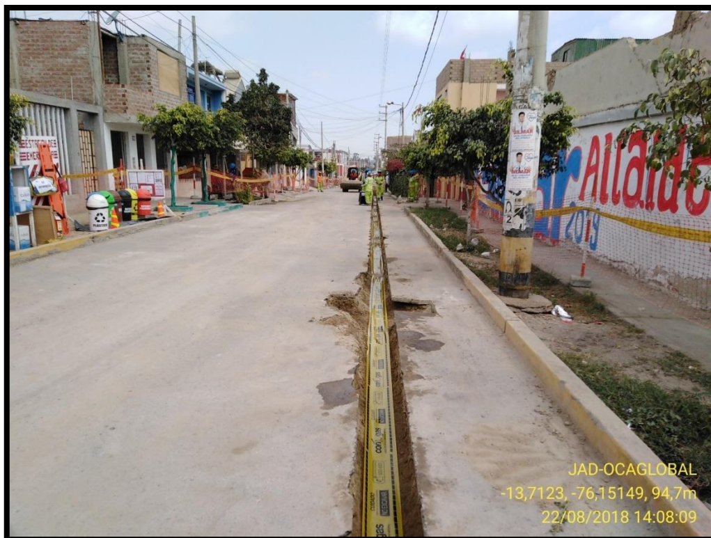
Imagen 24: Instalación de cinta de no excavar Fuente: Fotografía propia
