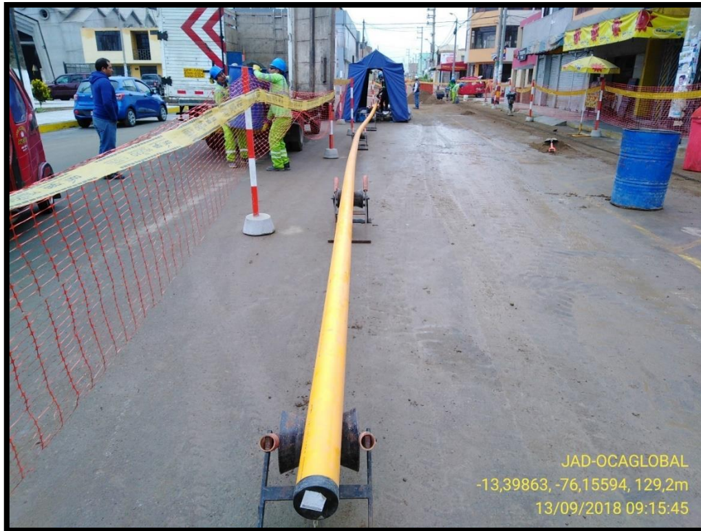
Imagen 14: Lingada de tubería de polietileno de 90 mm. fusionada a tope
