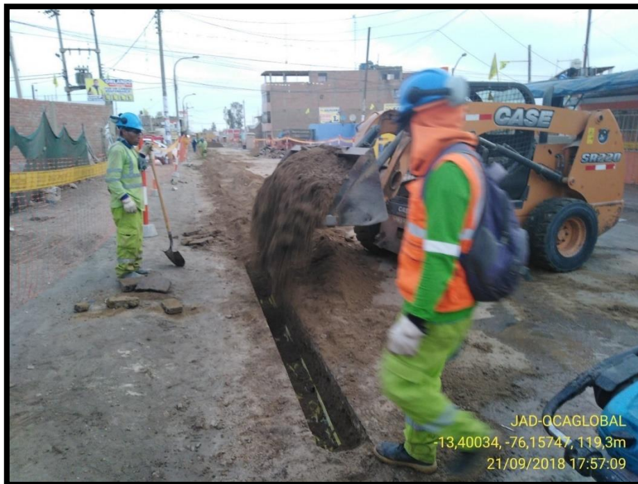
Imagen 49: Relleno de material de préstamo, afirmado
