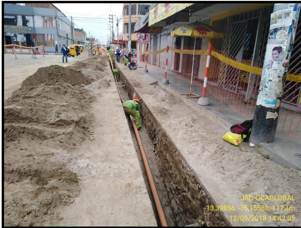
Imagen 15: Tendido de tubería de polietileno de 90 mm.
