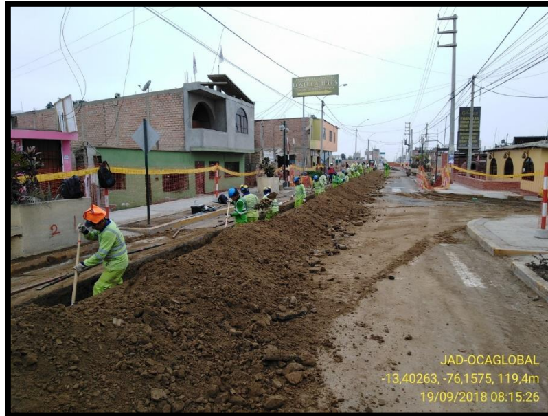
Imagen 39: Excavación manual Fuente: Fotografía propia
