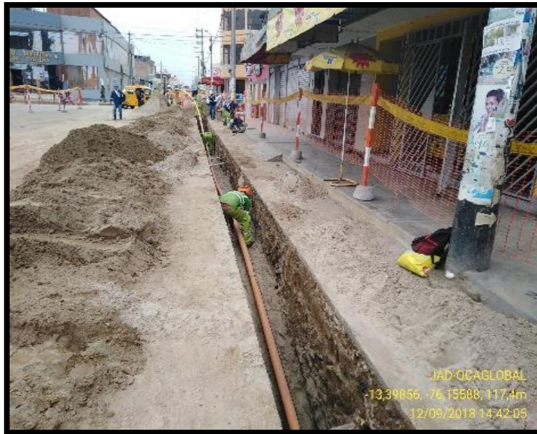
Imagen 43: tendido de tubería de polietileno de 90 mm Fuente: Fotografía propia
