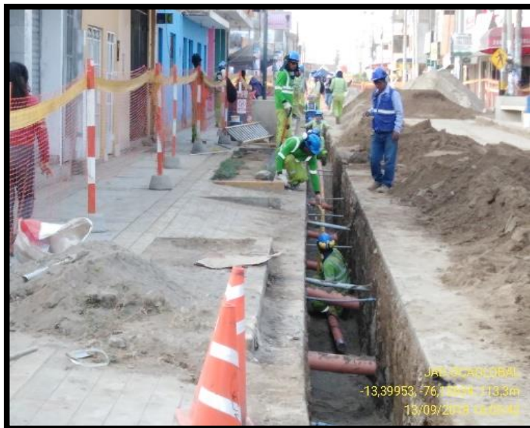
Imagen 44: Tendido de tubería de polietileno de 90 mm. a través de interferencias Fuente: Fotografía propia
