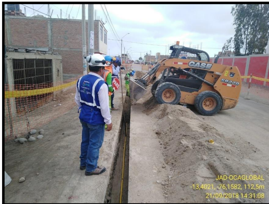
Imagen 47: Relleno de cama de arena superior Fuente: Fotografía propia
