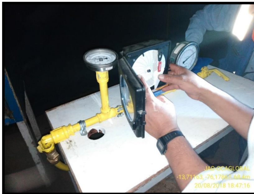
Imagen 59: Colocación de carta manográfica para iniciar la prueba de hermeticidad Fuente: Fotografía propia
