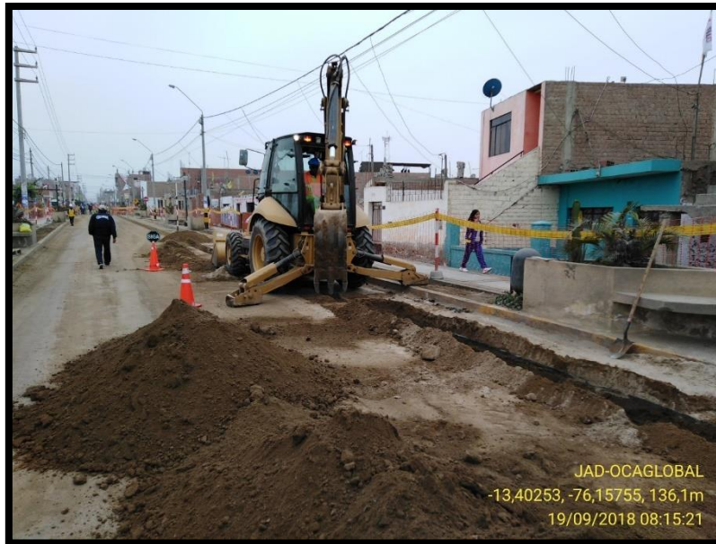
Imagen 40: Excavación mecánica con retro excavadora Fuente: Fotografía propia
