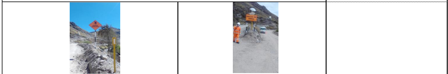
Figura N°1: Trabajos de señalización.
