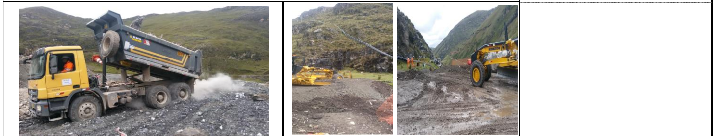
Figura N°1: Eliminación de material de demolición.
