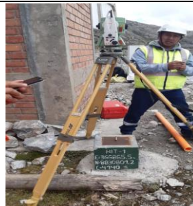
Figura N° 2: Trazo y replanteo.
