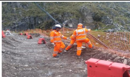
Figura N°1: señalización de las vías peatonales.
