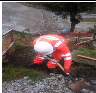
Figura N° 1: Habilitación de accesos.
