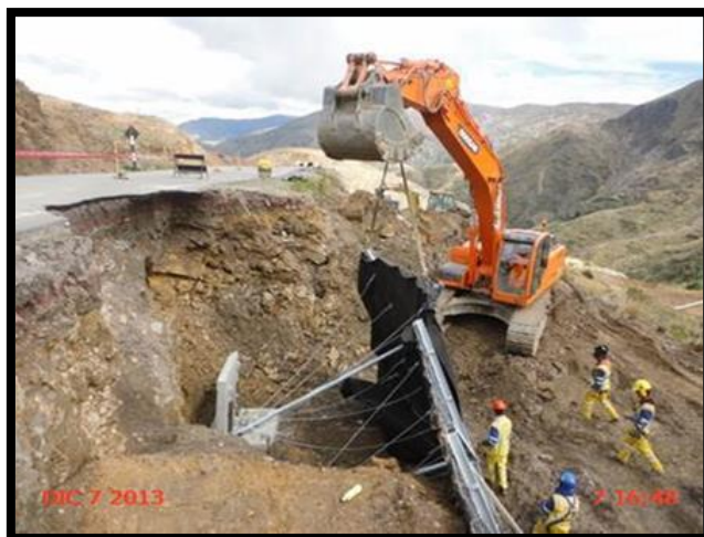
Figura 24 Se observa la colocación de un panel– Erdox con la ayuda de una Excavadora.
