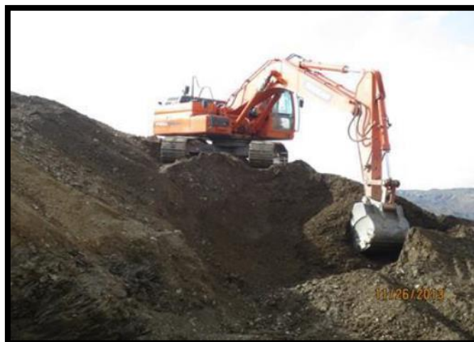
Figura 19 Se observa la actividad de excavación en el Sector Km. 11+500 de la Carretera Interoceánica Cusco – Puerto Maldonado.
