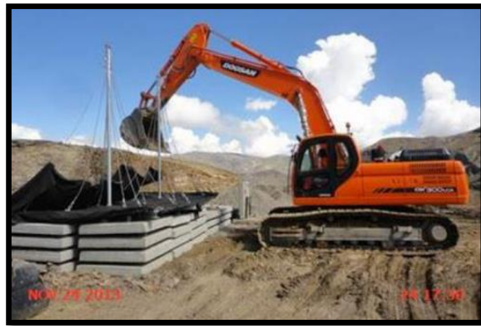
Figura 23 Se observa el Izaje de los Paneles– Erdox con la ayuda de una Excavadora.
