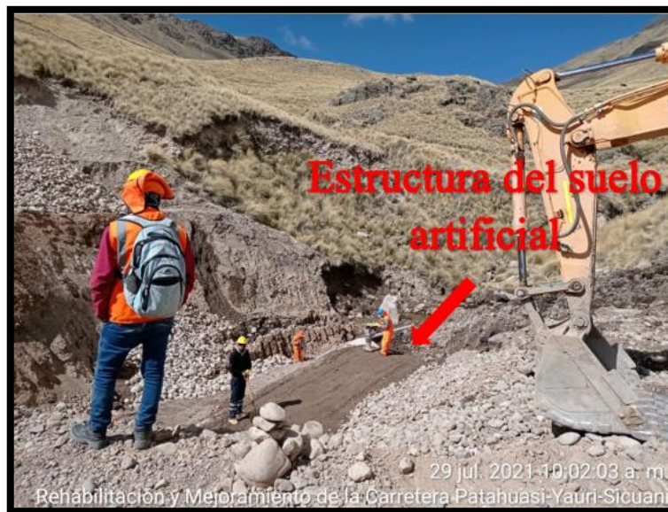
Figura 9 Talud de relleno
