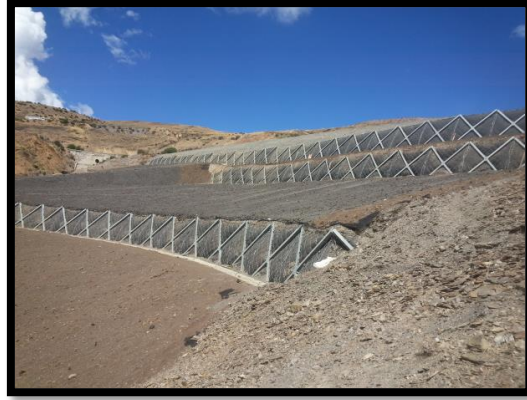
Figura 28 Se observa la Geomanta colocada sobre cada uno de los andenes de Erdox.
