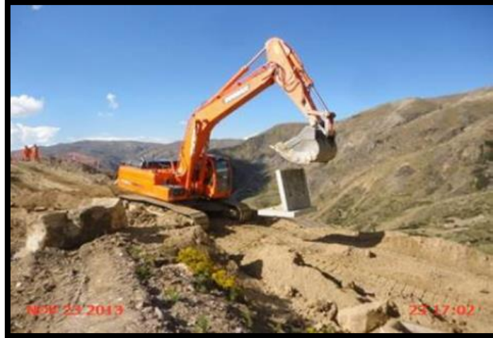
Figura 22 Se observa el transporte de las Placas de Anclaje ensambladas con la ayuda de una Excavadora.
