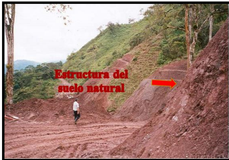
Figura 7 Talud de corte.
