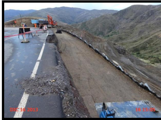
Figura 26 Se observa la compactación realizada sobre la estructura.
