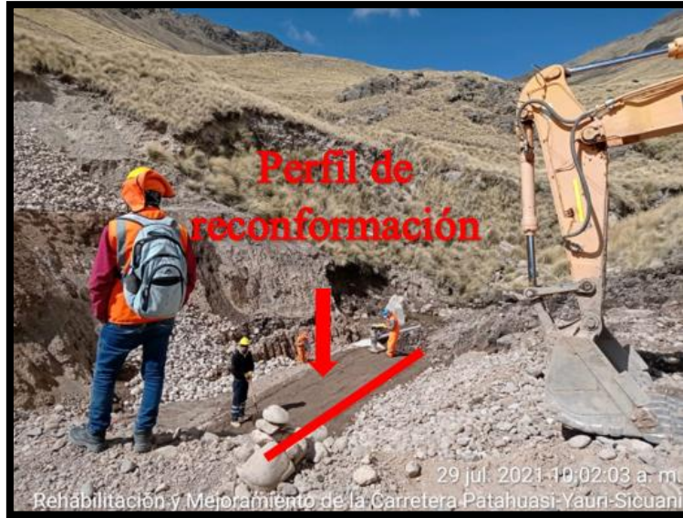
Figura 8 Talud de relleno
