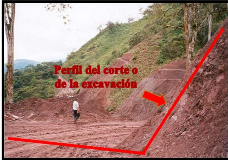
Figura 6 Talud de corte.
