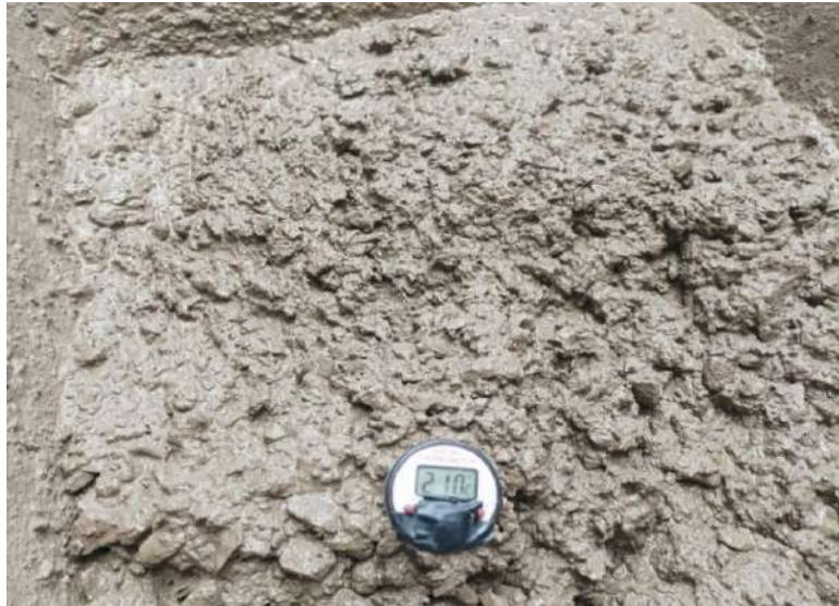
Figura 52. Medición de temperatura en el concreto fresco.
