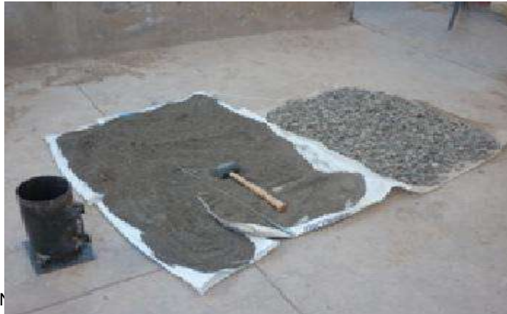
Figura 12. Tendido de los agregados a utilizarse.
