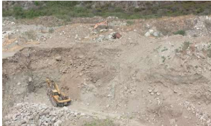
Figura 2. Depredación de Canteras en la ciudad de Abancay.
