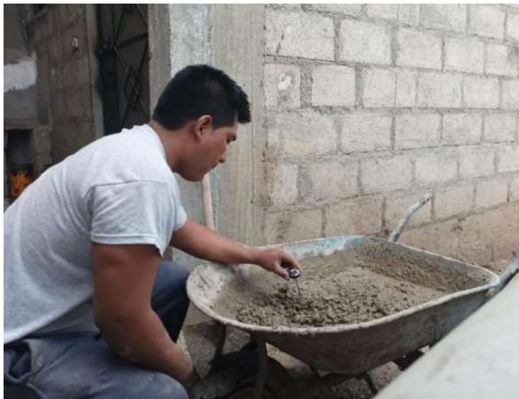
Figura 51. Toma y registro de temperatura en el concreto fresco.
