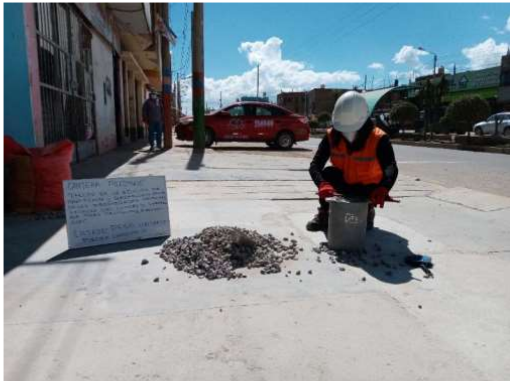
Fotografía N°06: Proceso de raseado del agregado grueso para la determinación del PUC.
