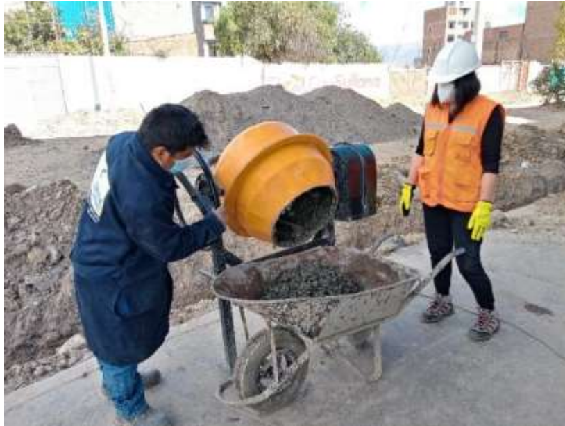
Figura 33. Mezclado del Concreto Permeable
