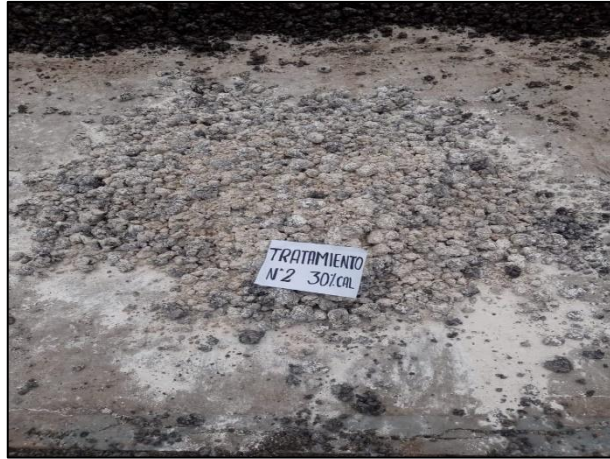
Fotografía 4. Tratamiento con el 30 % de cal.
