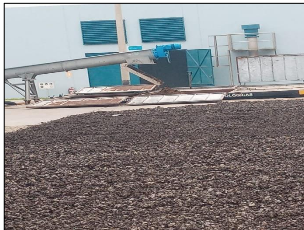
Fotografía 1. Salida de los lodos de la PTAR de Manchay.
