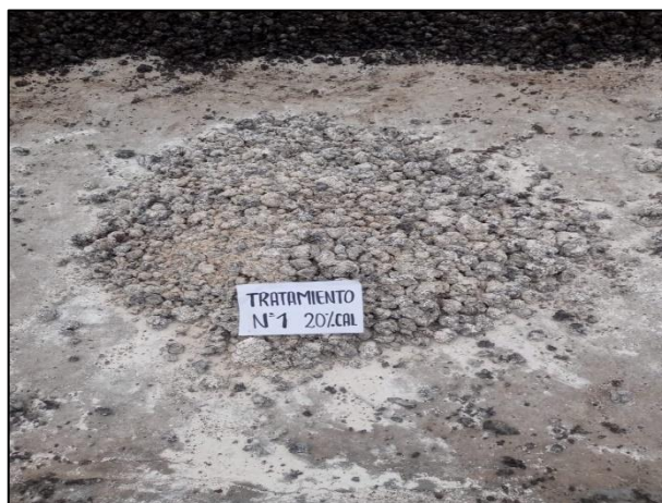
Fotografía 3. Tratamiento con el 20 % de cal.
