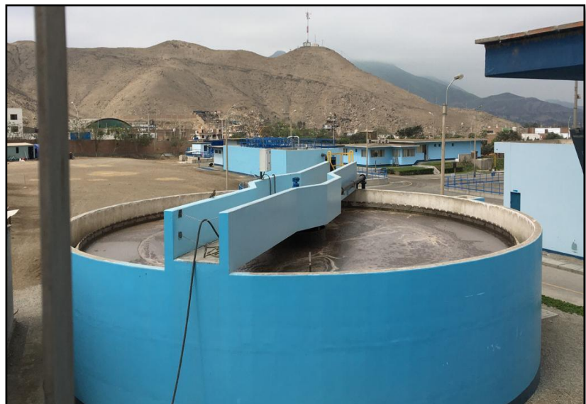
Figura 9. Aireador de lodos.
