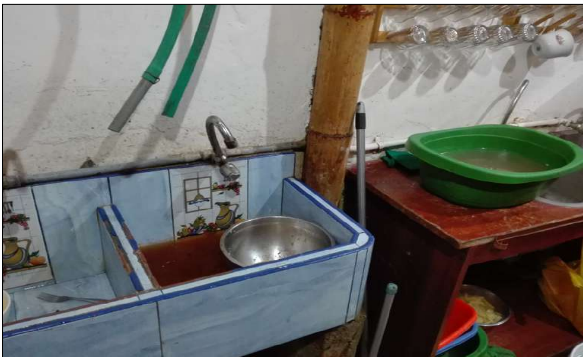
Figura 36. Lavadero de restaurante Las Tutis.
