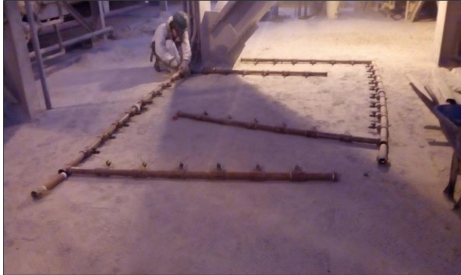
Figura 35. Armado de tubería hidro 3"
