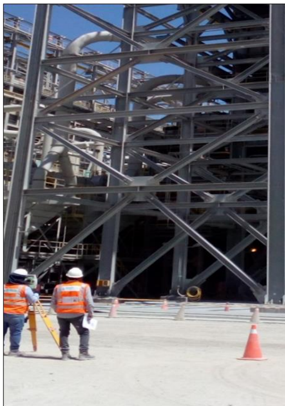
Figura 33. Toma de medidas con estación topográfica
