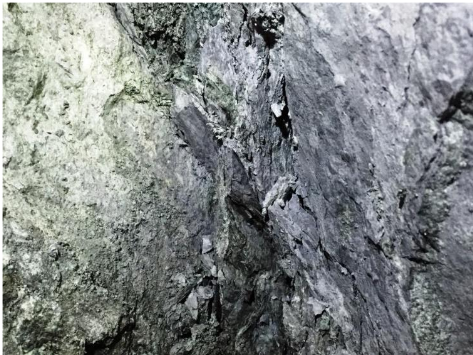
Figura 4. Roca intensamente fracturada y con alteración hidrotermal Tomada de Departamento de Geomecánica del Consorcio Minero Horizonte S. A. (8)
