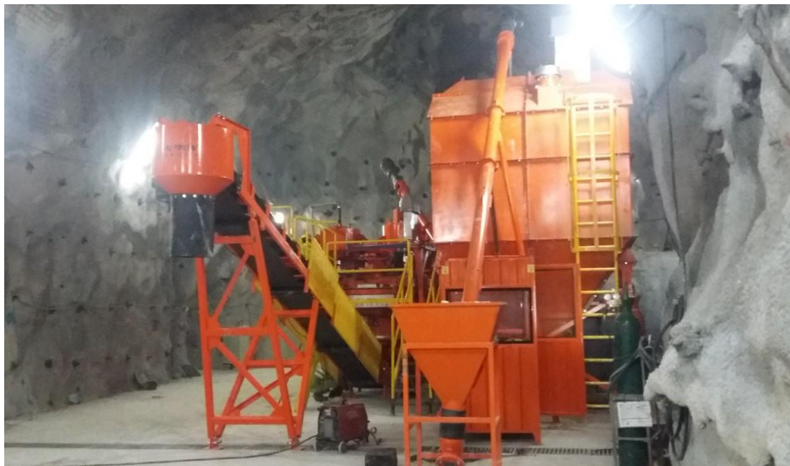
Tomada de Departamento de Planeamiento de la unidad minera Parcoy
