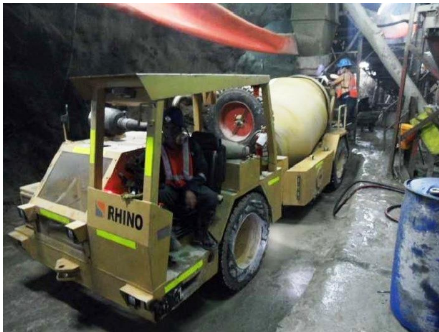
Figura 8. Abastecimiento de shotcrete vía húmeda - Planta dosificadora de shotcrete 1 Tomada de Departamento de Planeamiento de la unidad minera Parcoy
