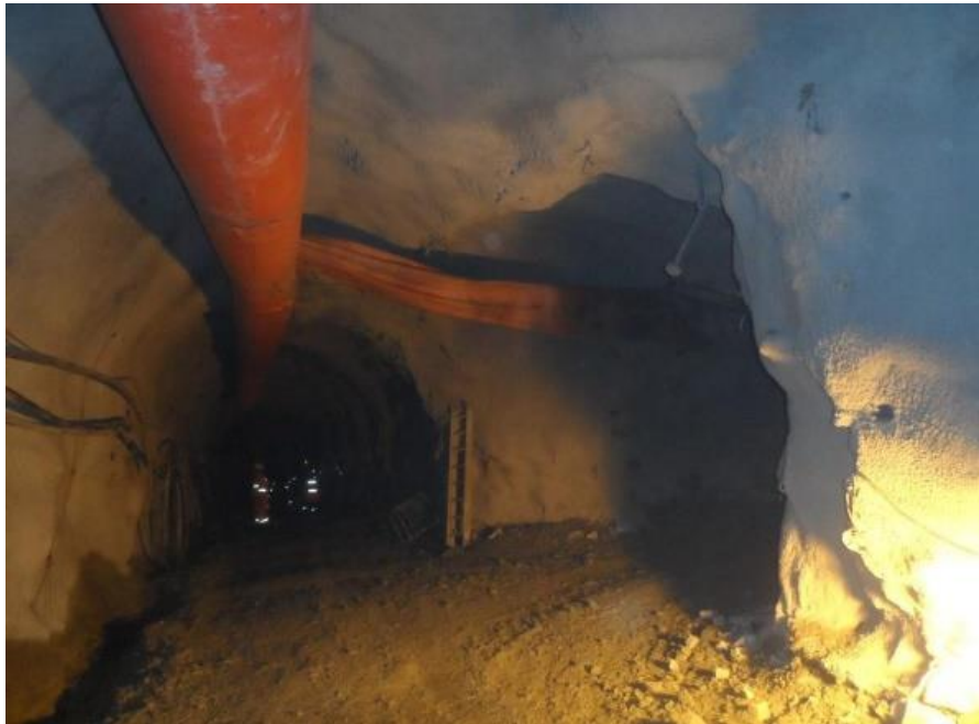
Figura 2. Intersección de labores con shotcrete y pernos sistemáticos Tomada de Departamento de Geomecánica del Consorcio Minero Horizonte S. A. (8)
