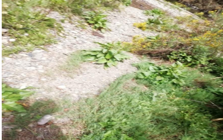
Fotografía 20. Acumulación de sedimentos durante años en la presa N° 1.
