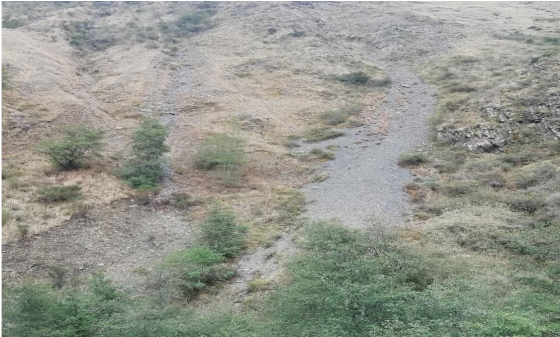
Fotografía 14. Deslizamiento de tierra.
