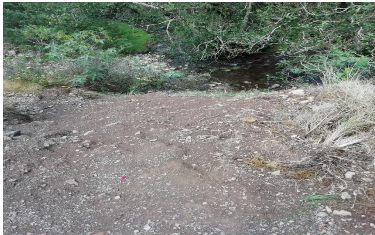
Fotografía 19. Deslizamiento de tierras aguas arriba de la presa N° 2.
