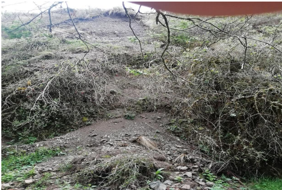
Fotografía 17. Deslizamiento de tierras aguas arriba de la presa N° 1.
