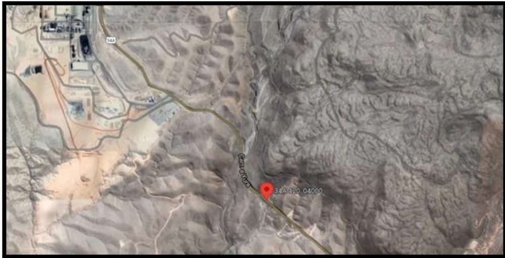
Figura 40. Localización mediante foto satelital de la posición del talud en la Vía 34-A Carretera a Yura progresiva 57+110 a la progresiva 57+200, perteneciente al tramo 5 de la carretera interoceánica.
