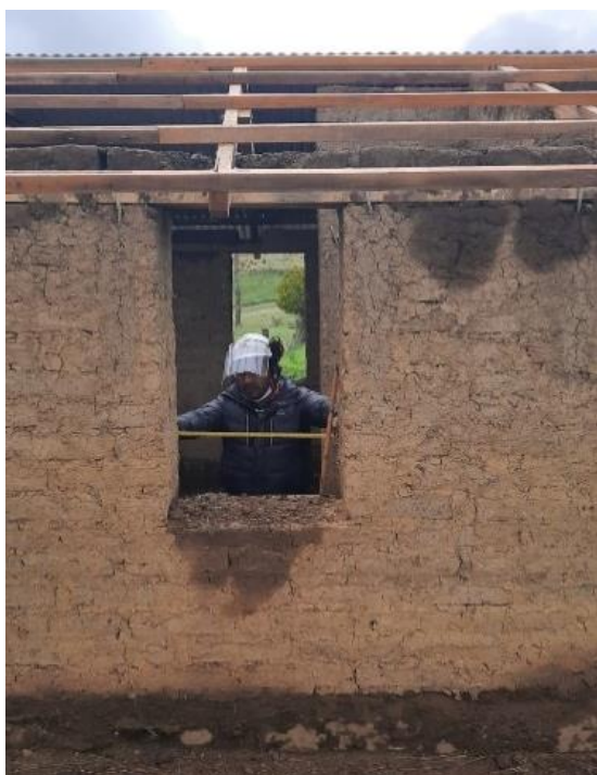
Figura 96. Paralelismo y uniformidad en instalación de tijerales
