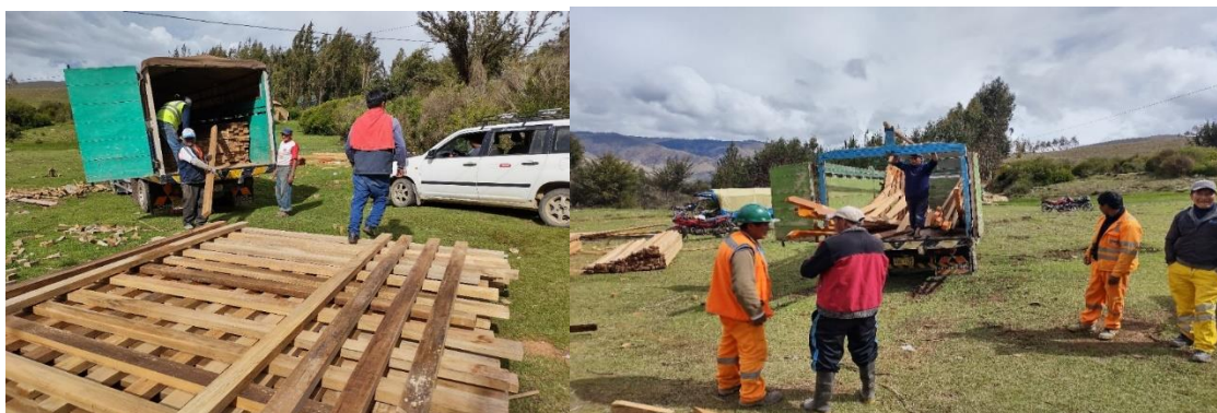
Figura 81. Descarga y transporte de materiales madera.
