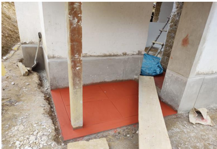
Figura 647. Vereda de concreto.
