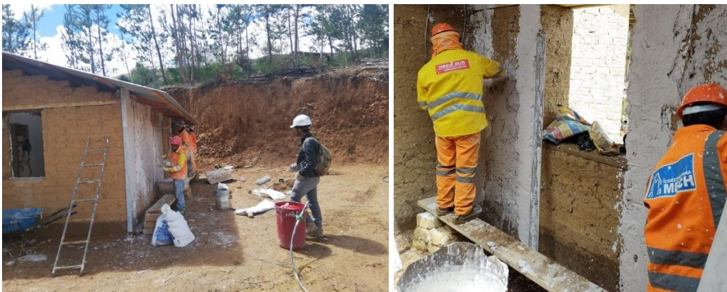
Figura 55. Enlucido con yeso exterior e interior.
