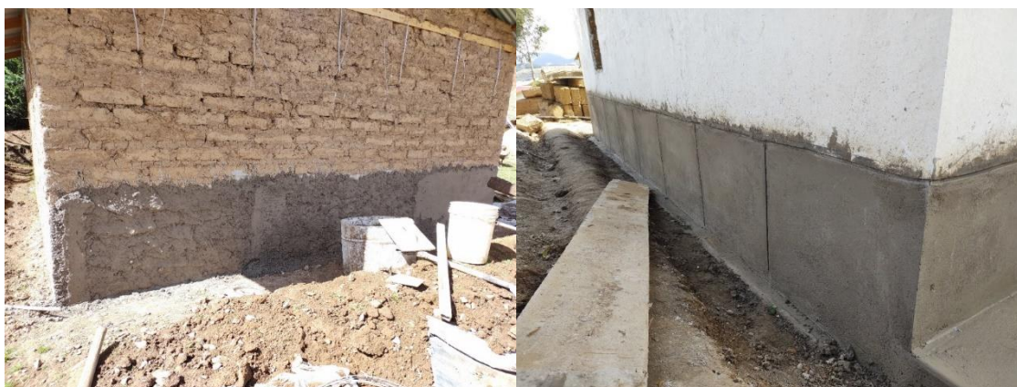
Figura 66. Zócalo de mortero exterior.
