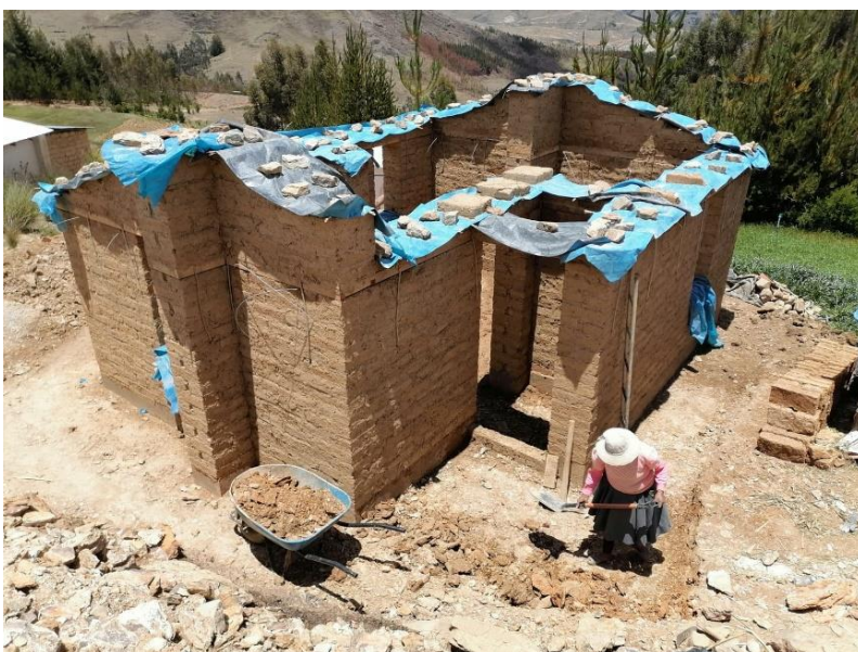
Figura 91. Protección de muros.
