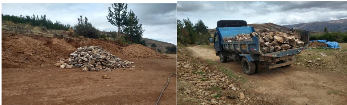
Figura 2. Suministro y transporte de piedra mediana y grande Nota. Elaboración propia.
