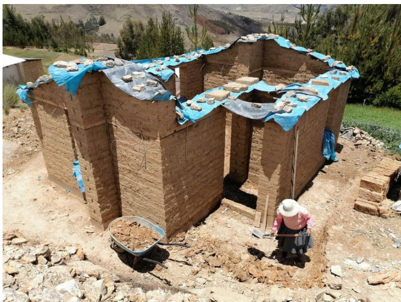
Figura 49. Protección de muros.
