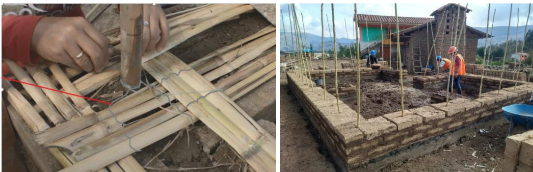
Figura 53. Reforzamiento vertical y horizontal de los muros
