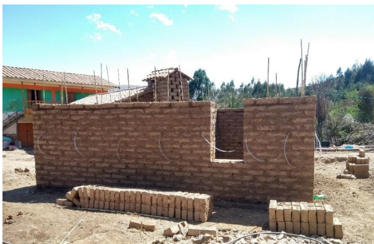
Figura 50. Muro de adobe
