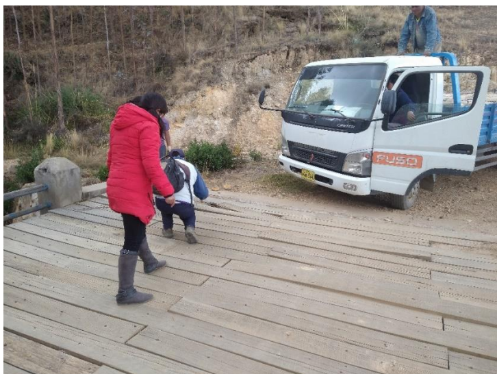
Figura 713. Transporte de material excedente.
