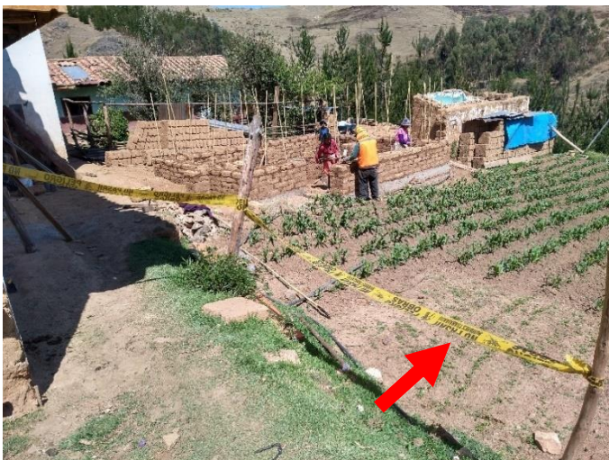
Figura 26. Señalización temporal de seguridad.
