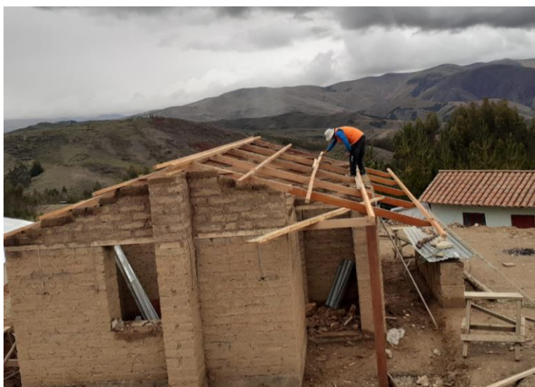
Figura 43. Instalación de tijerales y correas de madera.
