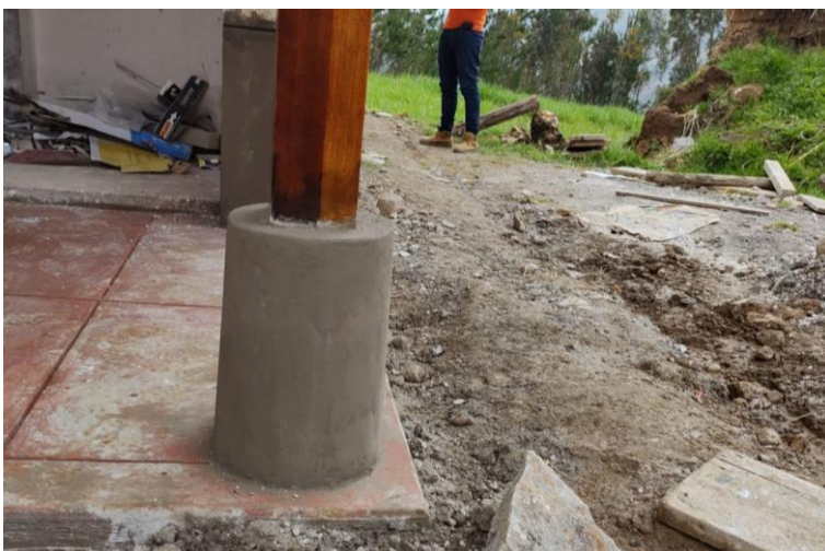
Figura 38. Zócalo de concreto para columna.
