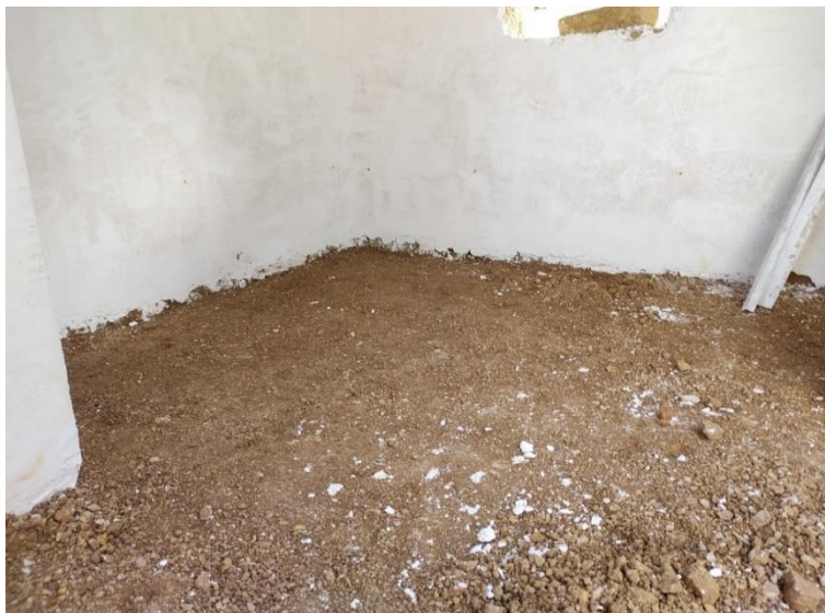
Figura 625. Nivelado y compactado.
