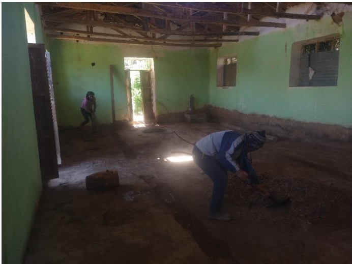
Figura 128. Limpieza de almacén de obra.
