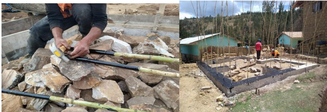
Figura 36. Carrizo de refuerzo y encofrado de sobrecimientos
