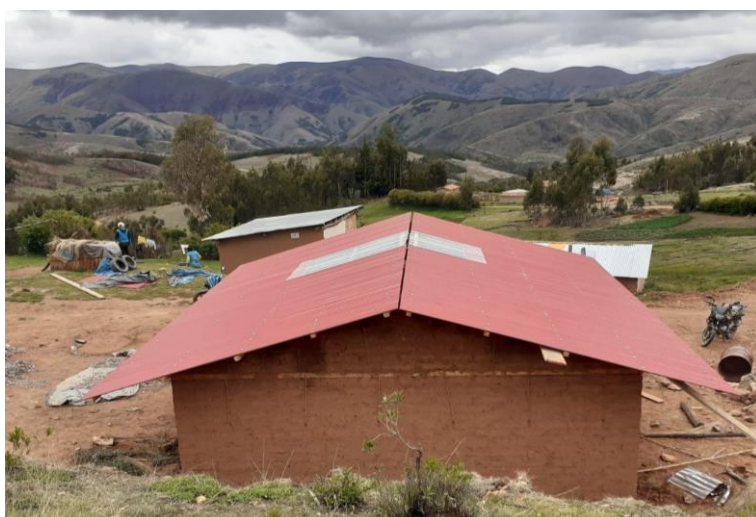
Figura 46. Coberturas de planchas de calamina.
