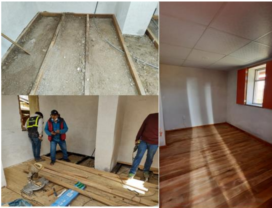
Figura 636. Proceso de instalación de piso de madera.
