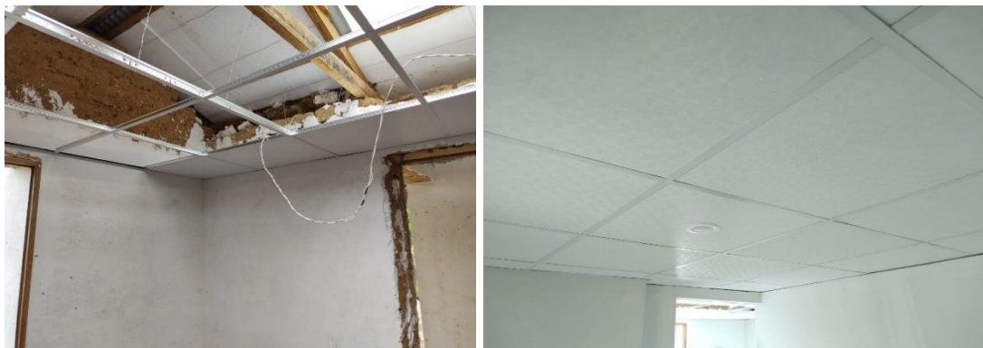
Figura 47. Instalación de cielo raso
