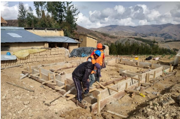
Figura 37. Encofrado de sobrecimientos
