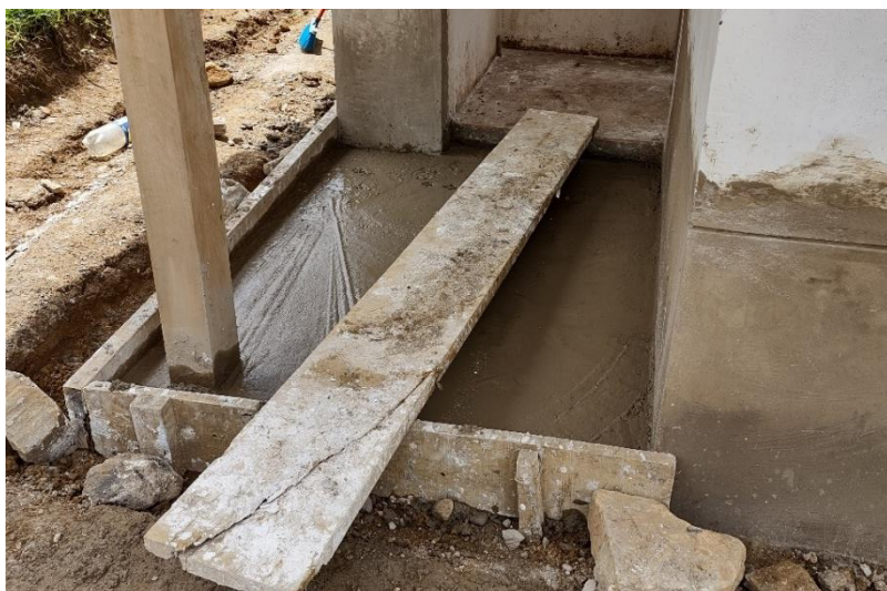
Figura 658. Encofrado de madera.
