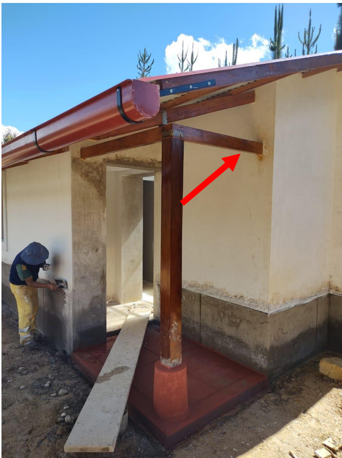
Figura 45. Viga de madera.
