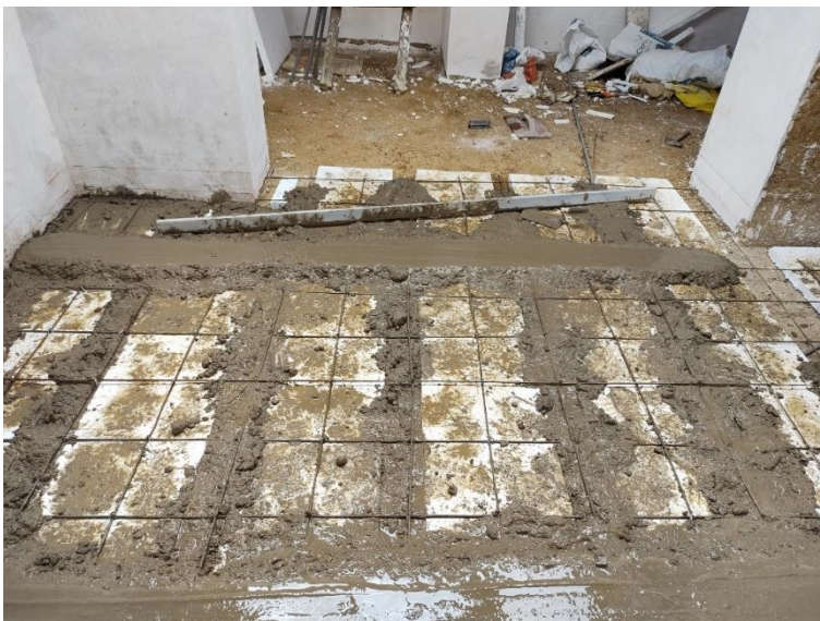
Figura 3. Vaciado de piso de concreto.
