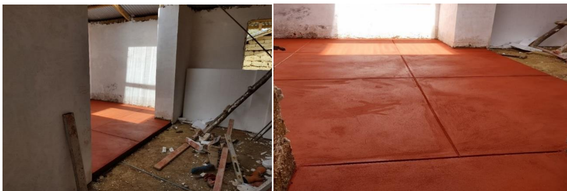
Figura 4. Piso de concreto.
