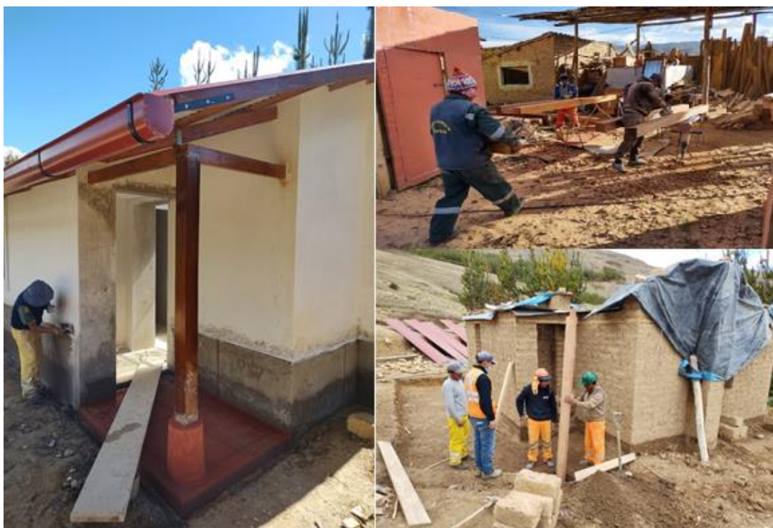
Figura 44. Proceso de instalación de columnas de madera.
