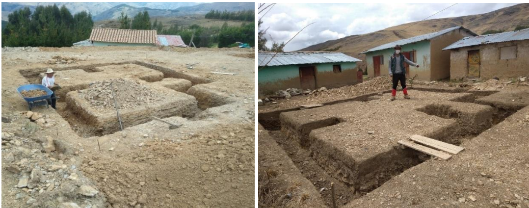
Figura 34. Excavación de zanja
