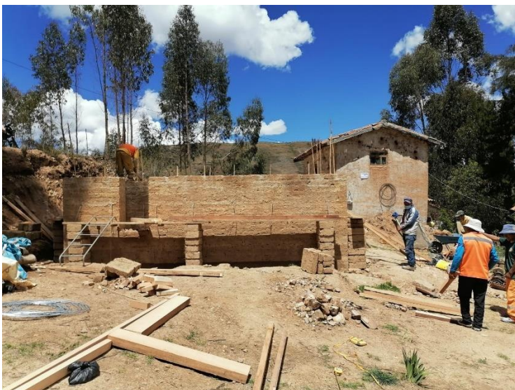
Figura 40. Dintel de madera.
