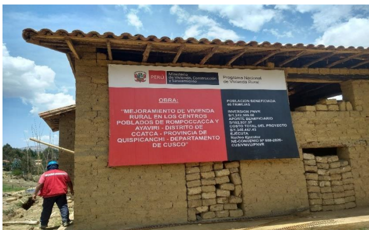
Figura 23. Cartel de obra.
