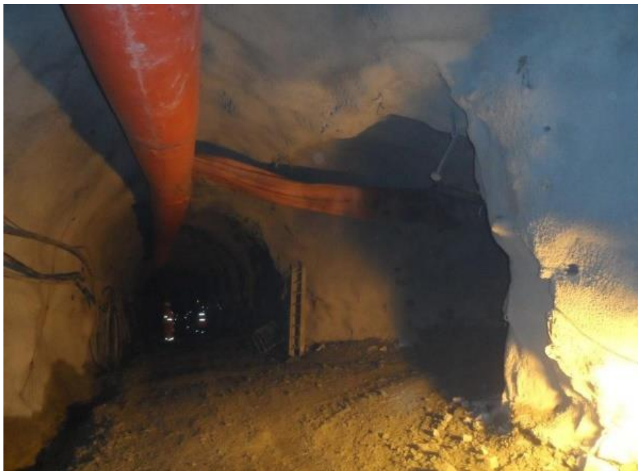
Figura 2: Intersección de labores con shotcrete y pernos sistemáticos.
