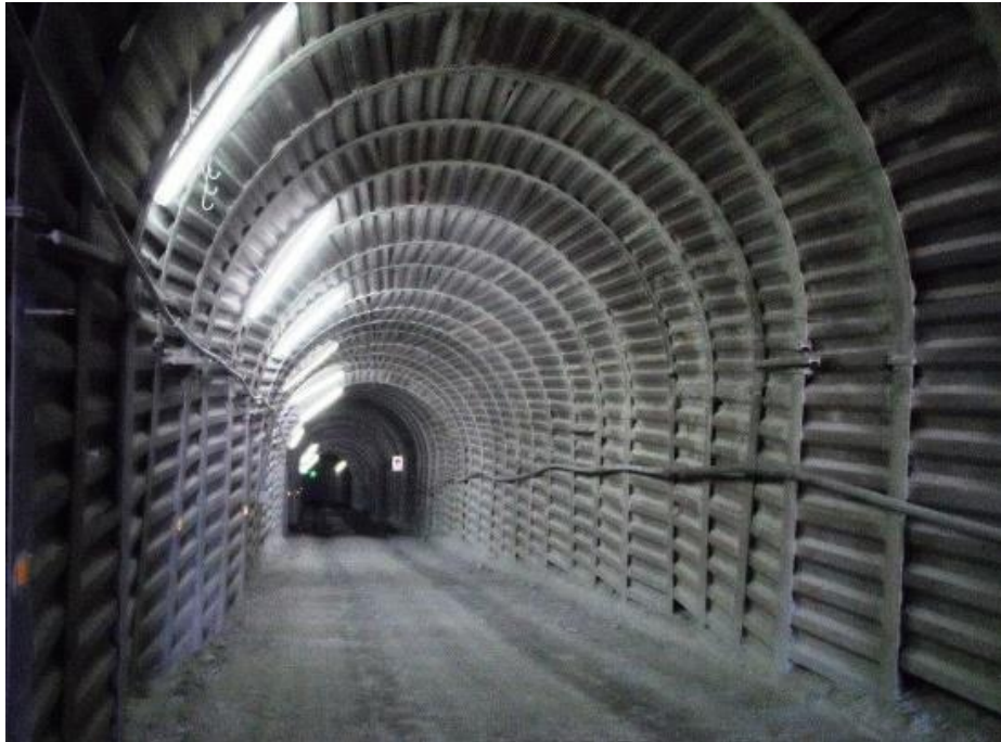
Figura 3: Sistema de cimbras para el sostenimiento de labores principales.
