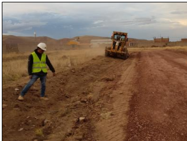
Figura 44. Habilitación de cunetas.
