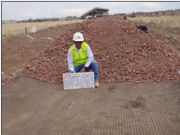
Figura 37. Vaciado de material de relleno sobre tramos de control y experimental.
