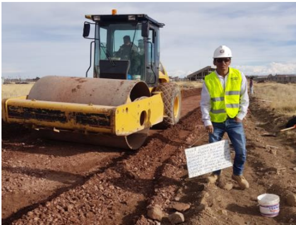
Figura 41. Compactado de material de relleno.
