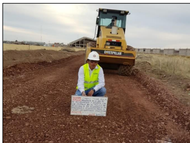
Figura 39. Compactado de material de relleno.
