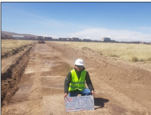
Figura 33. Desbroce y limpieza de terreno natural.
