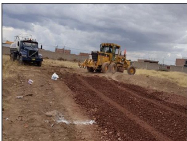
Figura 38. Conformación de material de relleno.
