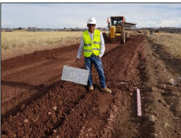
Figura 42. Reconformado de la subrasante.
