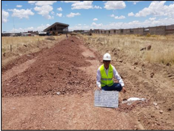
Figura 40. Vaciado del material de relleno.
