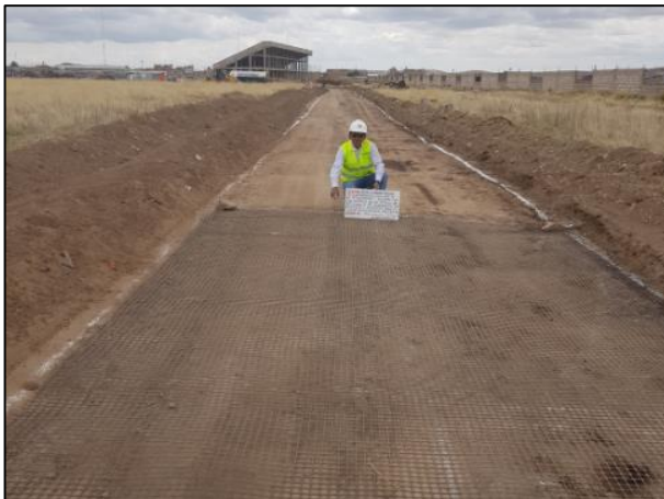
Figura 35. Extendido de geomalla biaxial en terreno natural.
