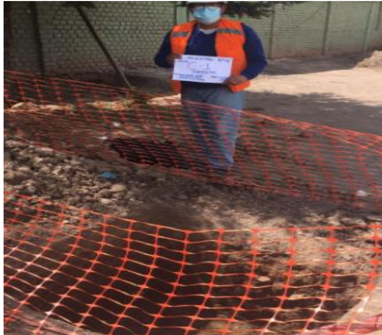
Figura 8.2 Calicatas Fuente: Elaboración Propia
