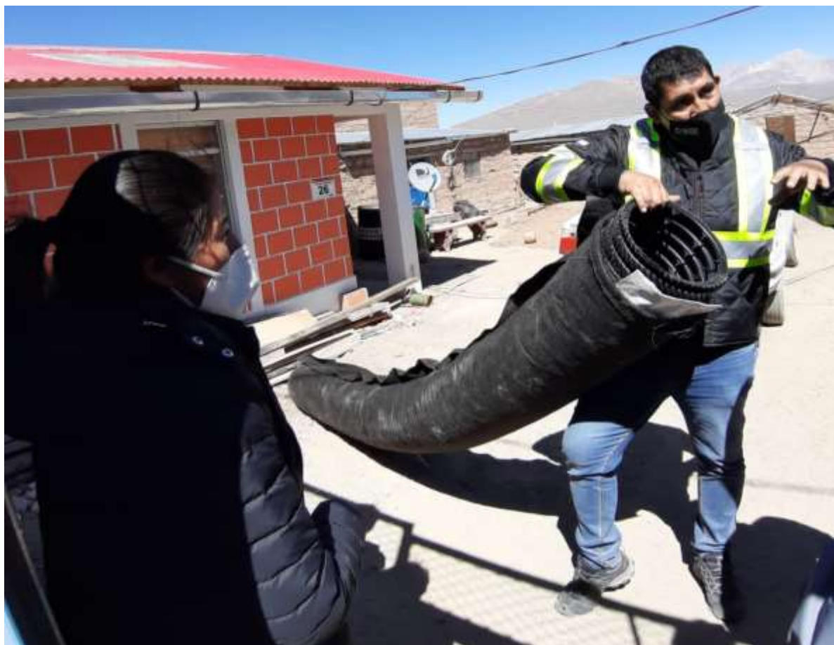
Fotografía N° 2: tecnología canadiense del System O)), los conductos del advanced enviro septic.
