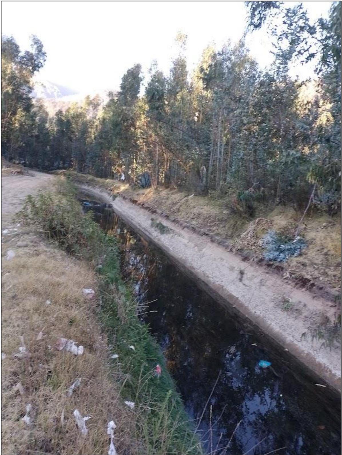
Figura 23. Canal CIMIRN Hualhuas.
