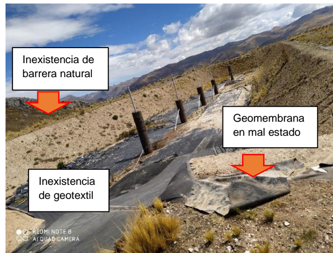
Figura 6. Trinchera de la Planta de tratamiento de Residuos Sólidos Pampachacra, (tomado en el lugar).
