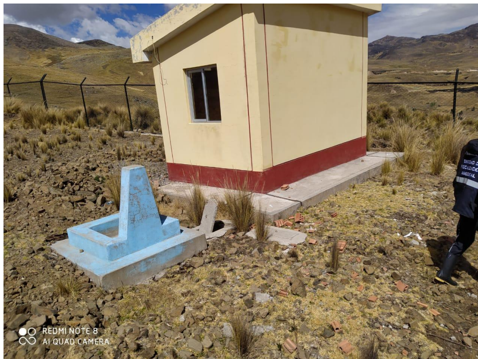
Fotografía 6. Gareta de vigilancia de la PTRS Pampachacra
