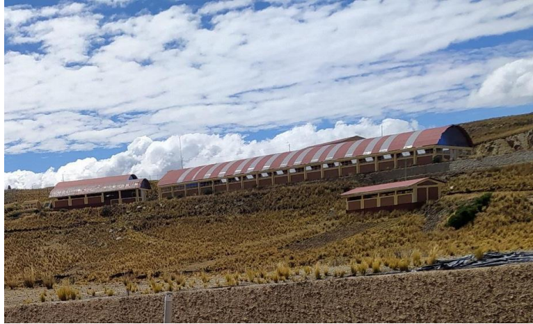
Figura 15. Oficinas administrativas, almacén, servicios higiénicos, vestuarios de la Planta de Tratamiento de Residuos Sólidos Pampachacra, (tomado en el lugar).
