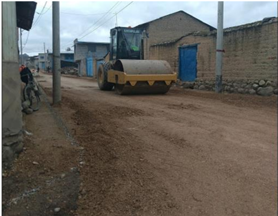
Figura 27. Compactación de terreno natural
