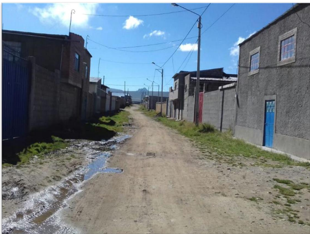
Figura 17. Jr. Torre Ugarte, vía deteriorada con presencia de baches
