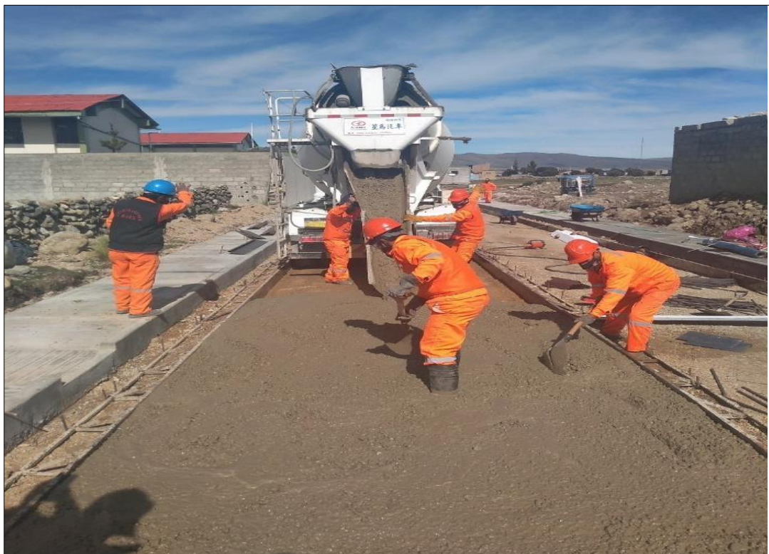
Figura 31. Conformación y llenado de concreto en pavimento
