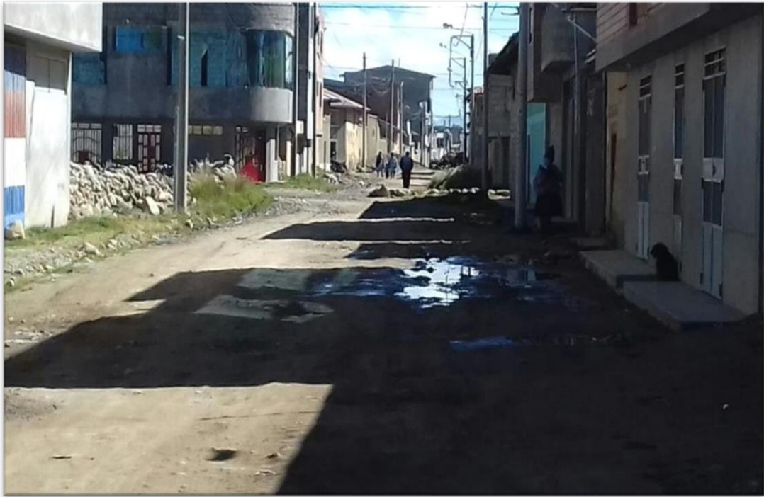
Figura 20. Jr. José La Mar, vía paralela a la carretera central, se encuentra deteriorada impidiendo el buen tránsito peatonal y vehicular
