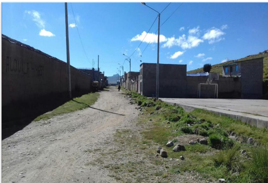
Figura 19. Jr. Francisco Pizarro, vía que comunica hasta losa deportiva, con presencia de baches en la vía
