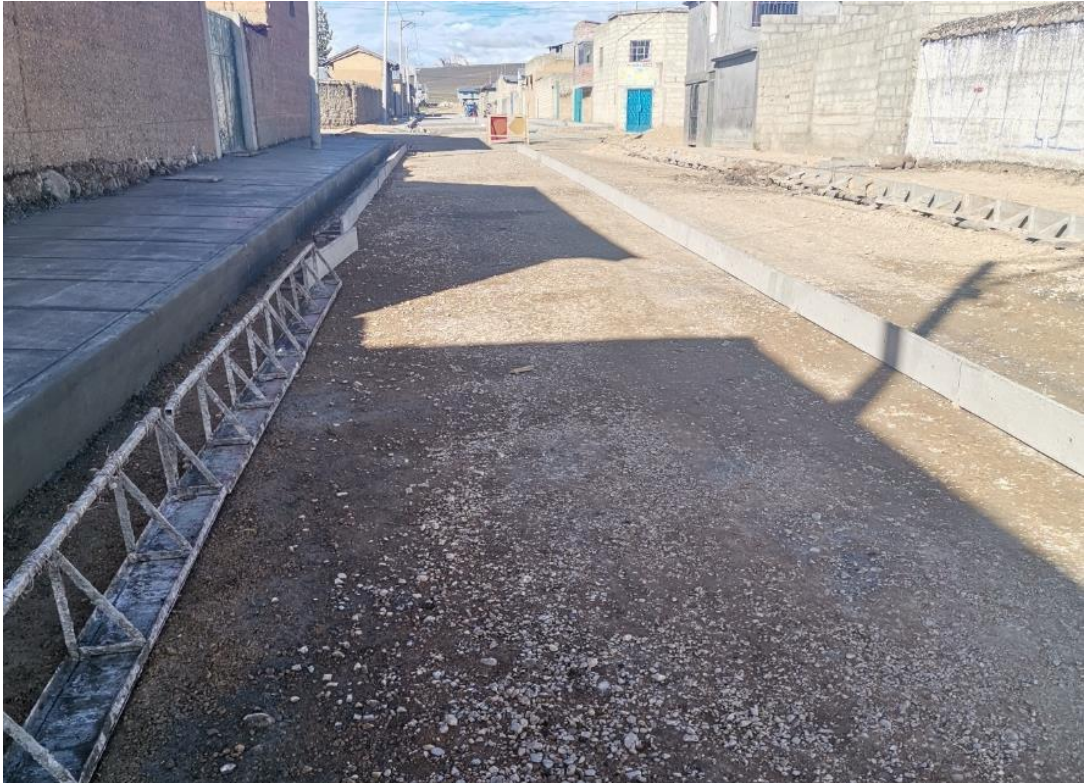
Figura 30. Encofrado de pavimento
