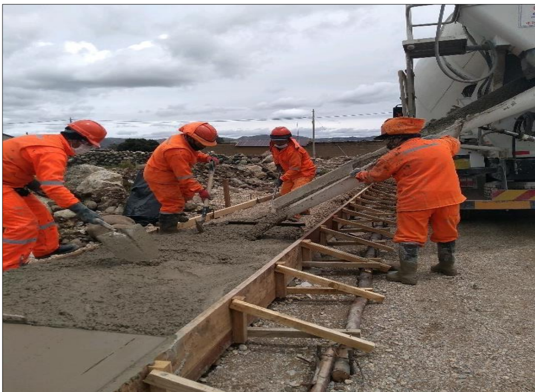
Figura 29. Conformación y llenado de veredas con concreto
