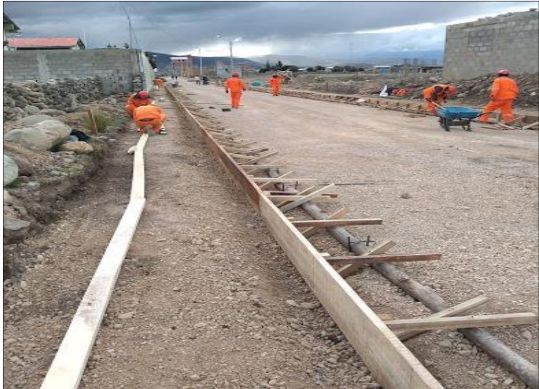
Figura 28. Encofrado de veredas
