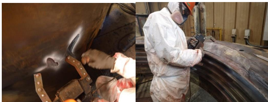
Figura 61. Eliminación de fisuras
