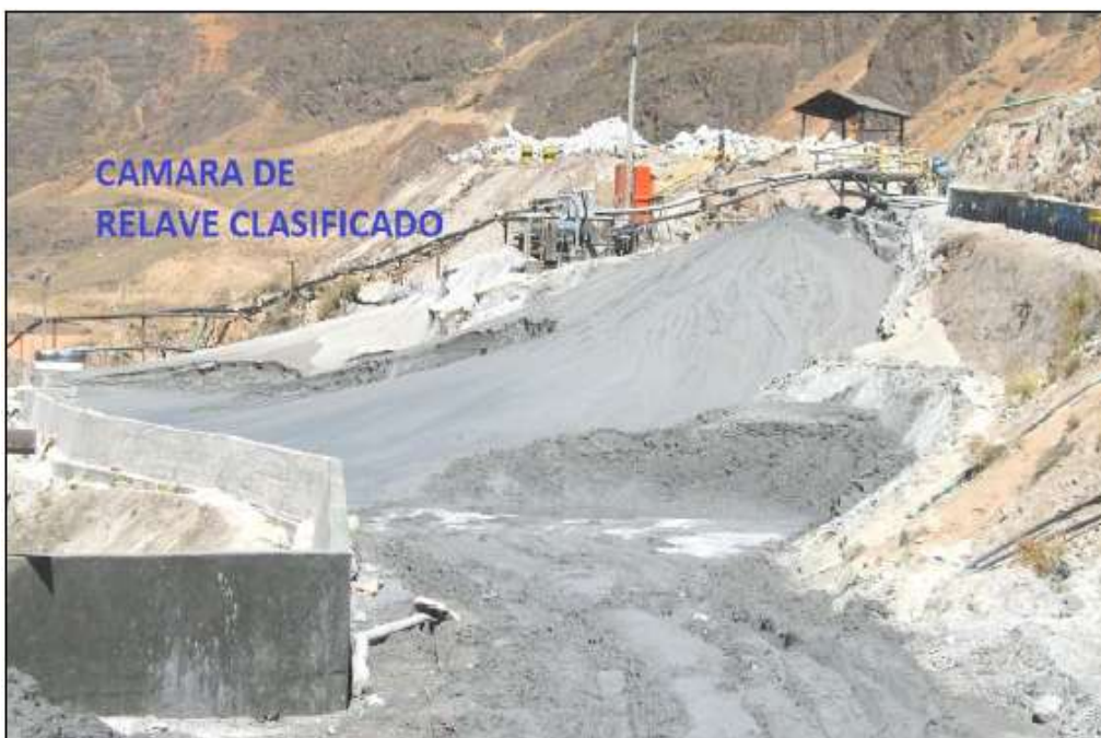
Figura 4. Cargador frontal de 5 yd 3 y la cámara de acumulación del relave clasificado con una capacidad de 400 t Tomada de Informe de prácticas preprofesionales -Yauli: Volcan Compañía Minera S. A., 2010 (11)
