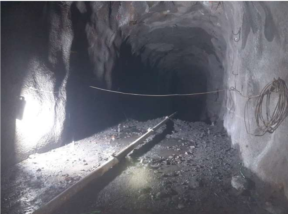
Tomada de Área de Servicios Mina - Yauli: unidad minera Andaychagua, 2020
