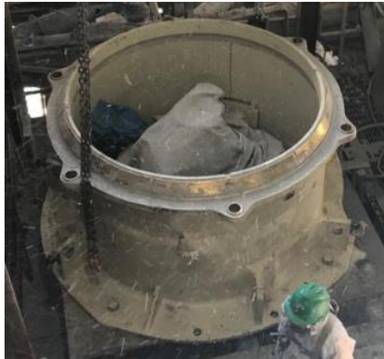
Figura 46. Montaje de Main Frame
