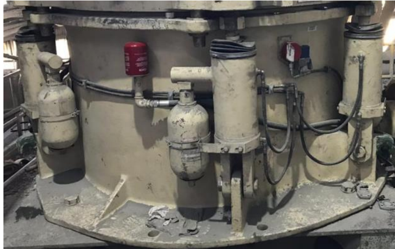
Figura 56. Instalación de mangueras hidráulicas
