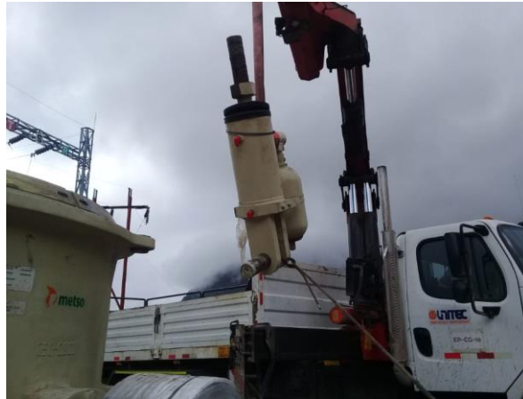
Figura 34. Desmontaje de componentes hidráulicos de alivios de la chancadora HP500, mangueras y acumuladores
