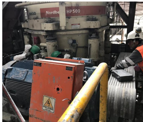
Figura 64. Instalación de fajas de transmisión
