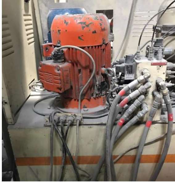
Figura 29. Desmontaje del sistema hidráulico
