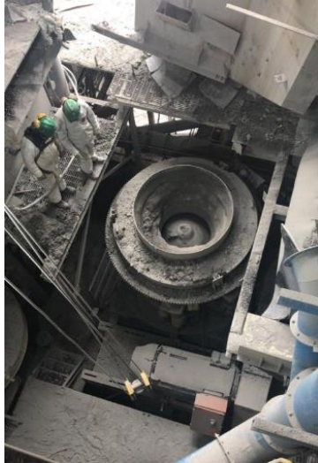
Figura 26. Desmontaje de chancadora HP500
