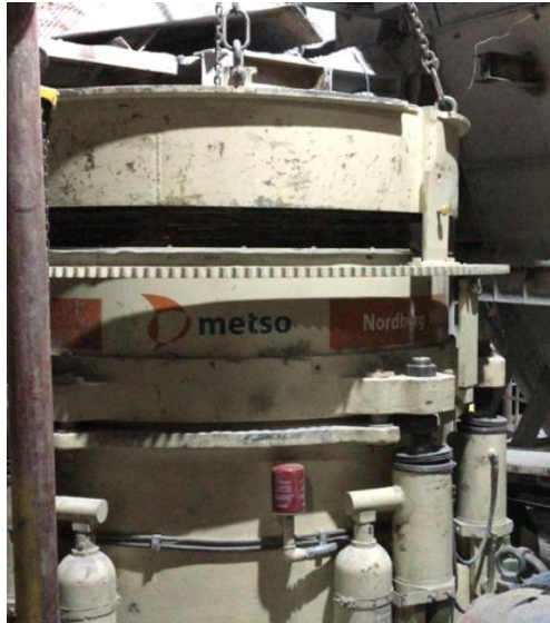
Figura 61. Instalación de Bowl
