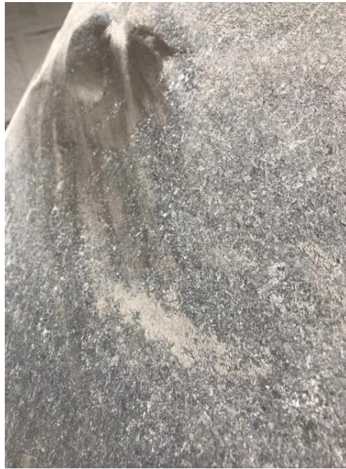
Figura 8. Impacto de la uña de excavadora en el blindaje del Head
