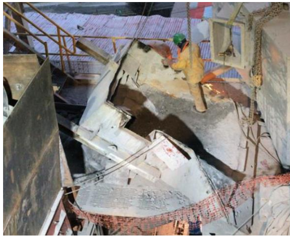
Figura 27. Retiro de chute de alimentación
