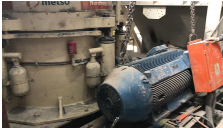
Figura 28. Desmontaje de motor
