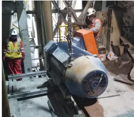
Figura 63. Montaje de motor
