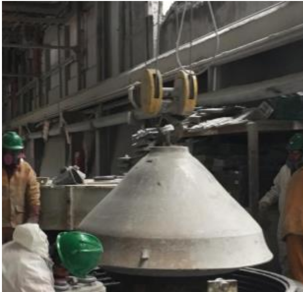
Figura 31. Desmontaje de Head
