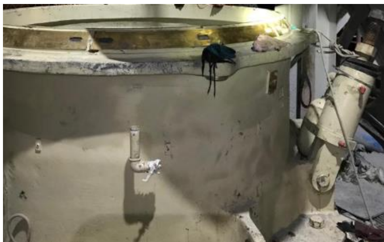
Figura 54. Montaje de gatos de alivio y componentes hidráulicos
