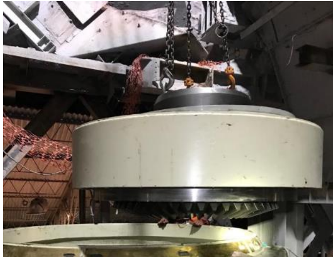
Figura 49. Montaje excéntrica y contrapeso
