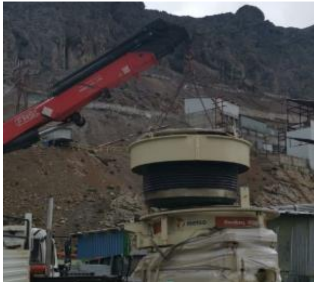
Figura 30. Desmontaje de Bowl Liner
