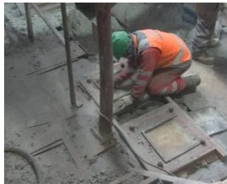
Figura 44. Nivelación del base de concreto y grouting con laines
