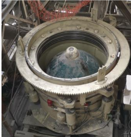
Figura 58. Instalación de Head
