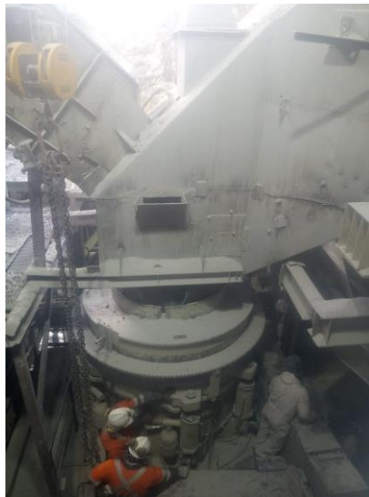
Figura 62. Instalación de chute de alimentación
