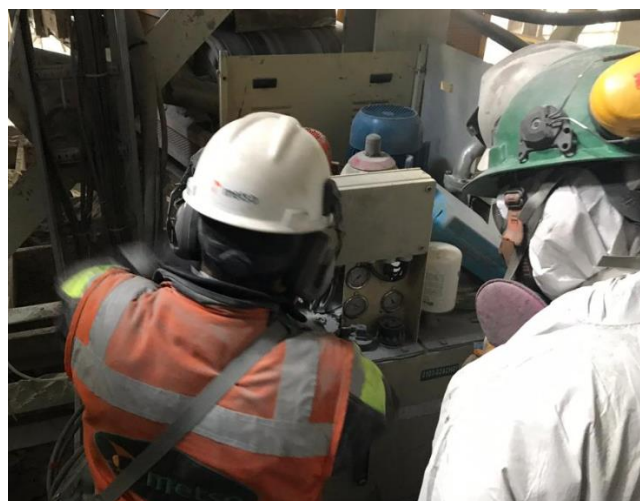
Figura 65. Instalación del sistema hidráulico del HPU
