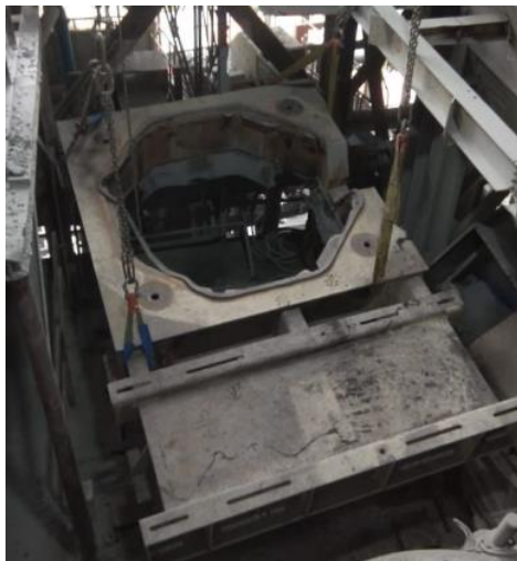
Figura 45. Montaje de Soleplate HP500
