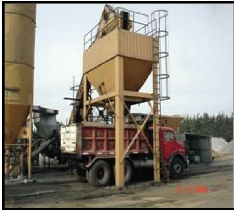
Figura 33: Planta de producción de pavimento asfáltico con caucho-asfalto
