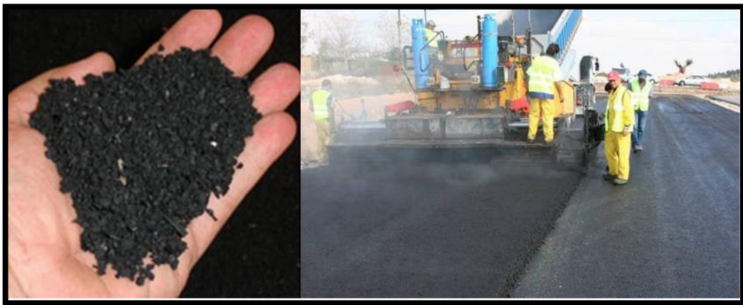
Figura 6: Pavimentación con mezcla asfáltica modificada con NFU.
