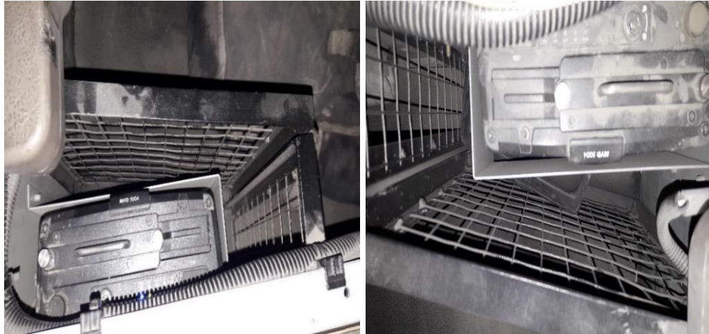
Figura 39. Evidencia instalación de rejillas
