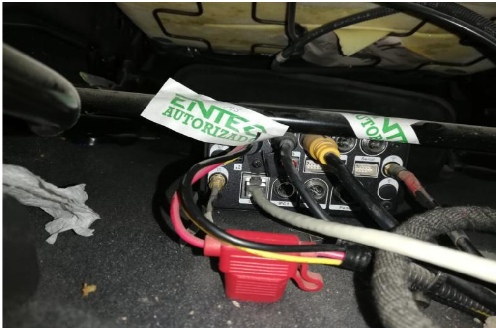
Figura 42. Extracción mediante cable de red
