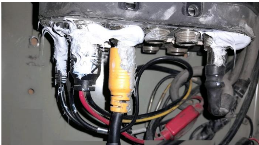
Figura 41. Aplicación de silicona a los conectores
