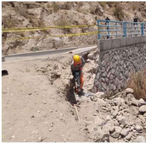
Demolición de estructuras de concreto
