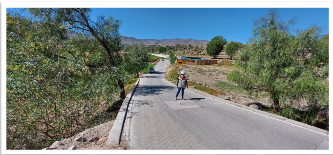
Pavimentación articulada terminada y colocación de buzón terminada
