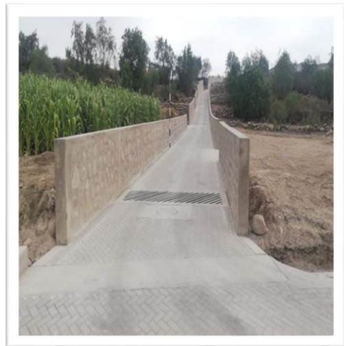
Estado final de las calles intervenidas
