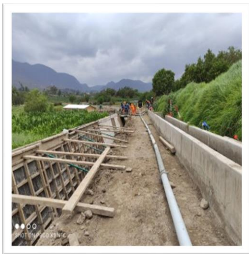
Vaciado de concreto premezclado en muros de contención
