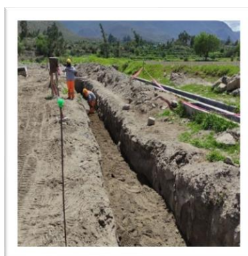
Colocación de relleno de excavación
