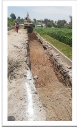
Excavación para muro de contención
