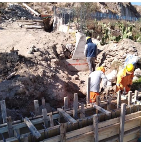
Encofrado de cruce de canal
