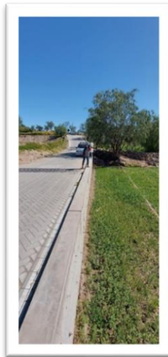
Muros de contención culminados
