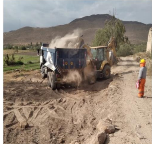
Eliminación de material excedente
