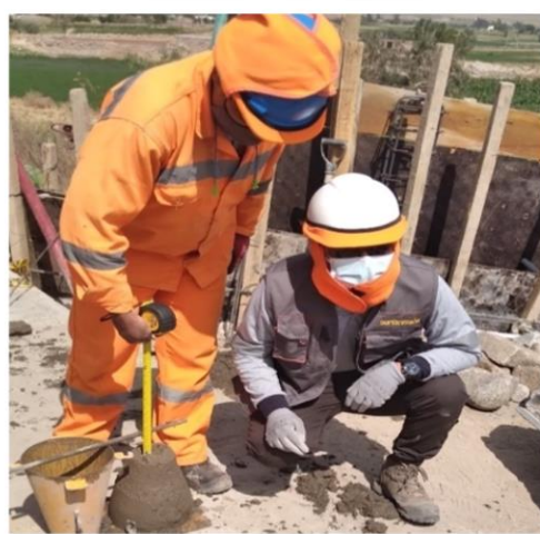
Control de asentamiento de concreto
