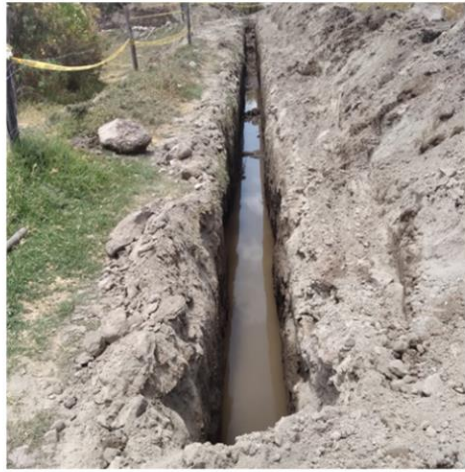
Excavación de terreno normal
