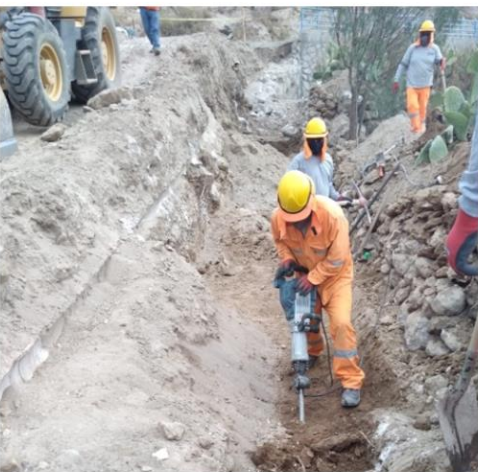
Excavación en terreno semirrocoso
