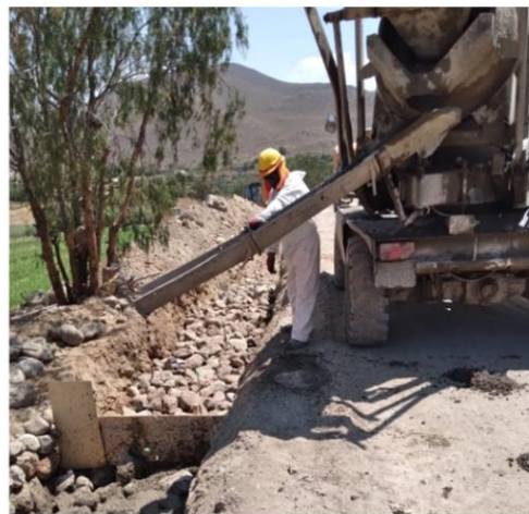
Vaciado de concreto ciclópeo
