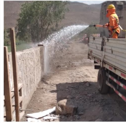
Curado de elementos estructurales
