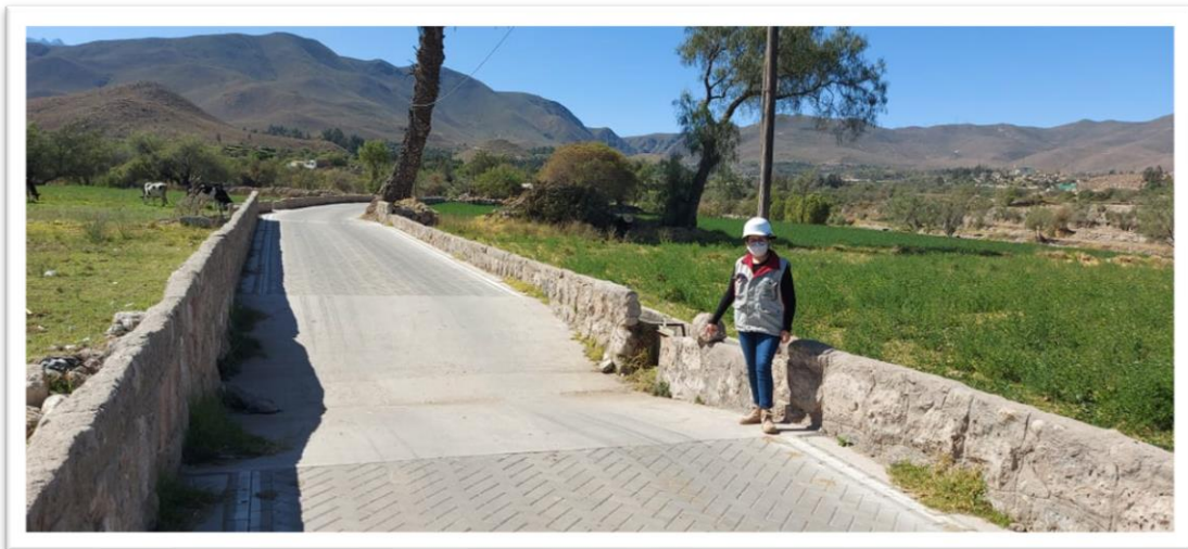
Baden de concreto culminado– progresiva 0+030
