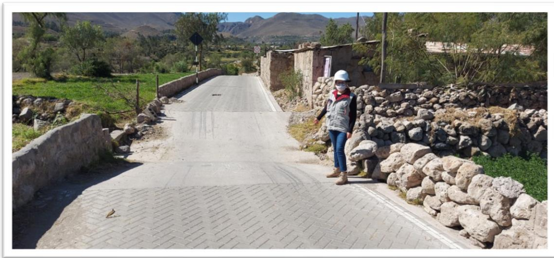
Rampa de concreto culminado – Progresiva 0+110
