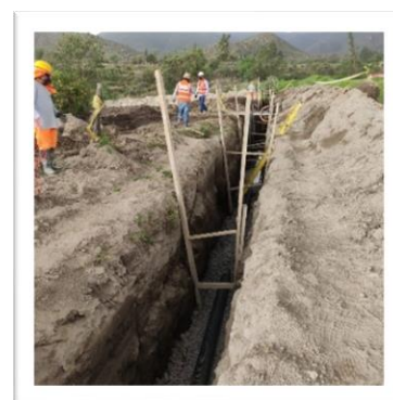
Colocación de tubería en zanja
