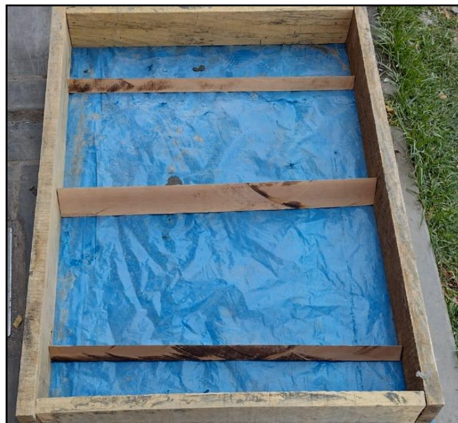
Figura 111. Molde de madera para la elaboración de losas de concreto.
