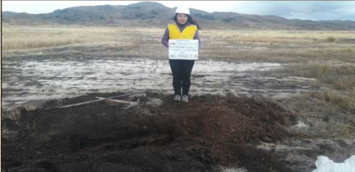
Figura 109. Exploración y muestreo de las calicatas - prog. 17+500 / C-06
