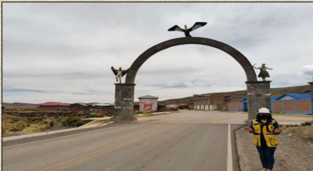
Figura 142. Carretera desvío Desaguadero – kelluyo, Distrito de Kelluyo
