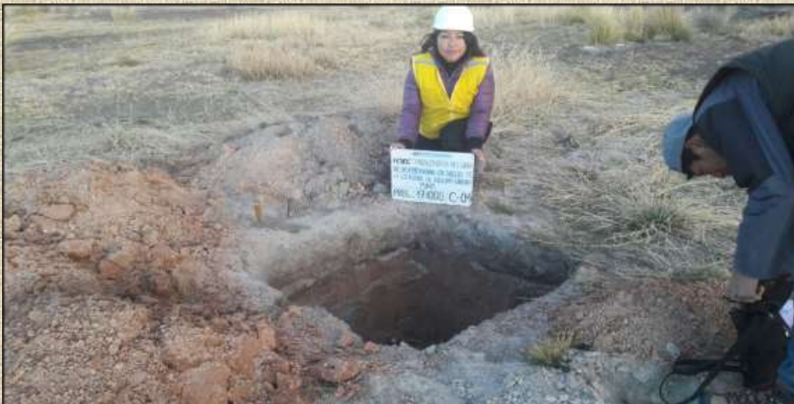
Figura 108. Exploración y muestreo de las calicatas - prog. 17+000 / C-04
