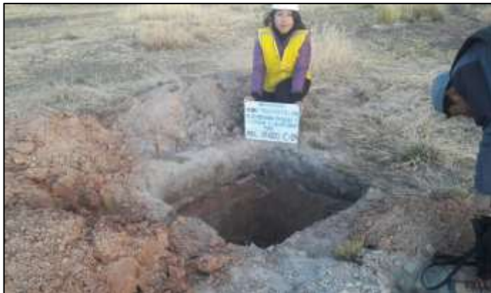
Figura 33. Fotografía de la Calicata 04 - Prog. 17+000
