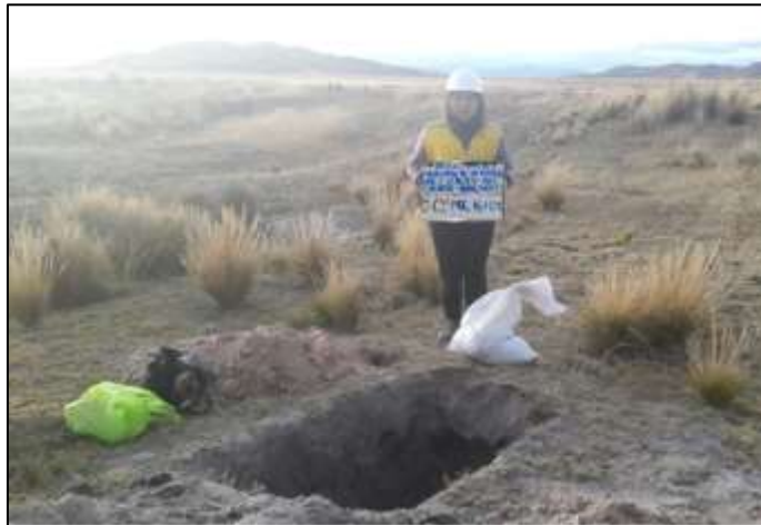
Figura 30. Fotografía de la Calicata 01 - Prog. 16+250
