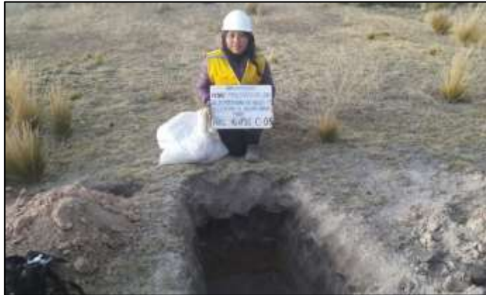
Figura 32. Fotografía de la Calicata 03 - Prog. 16+750
