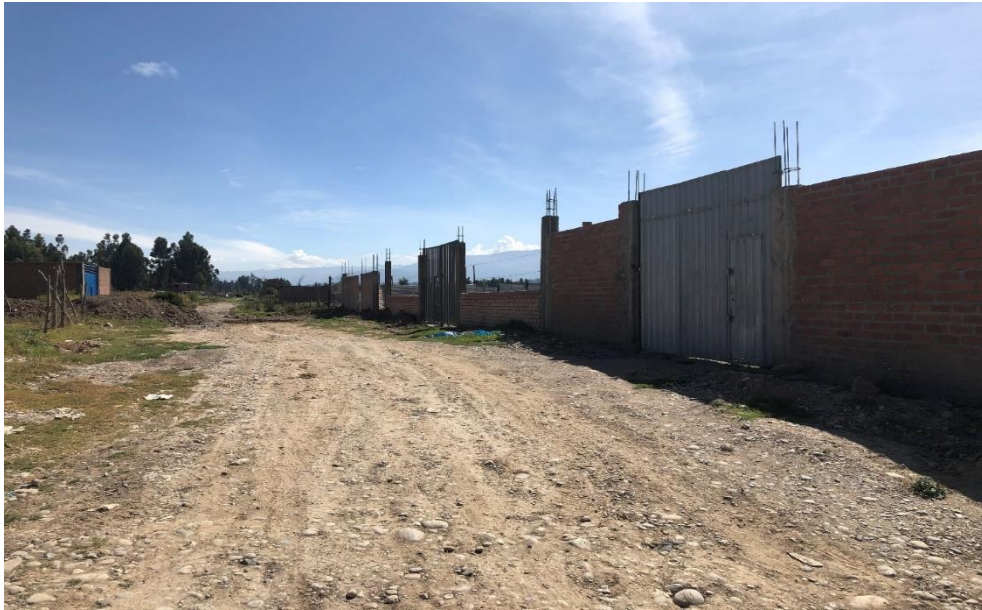
Figura 3. Vista de predios dentro de la franja marginal.
