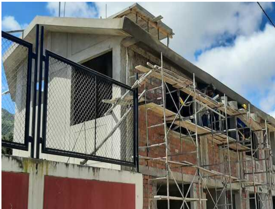
Figura 8. Muestra de construcción de oficinas administrativas.
