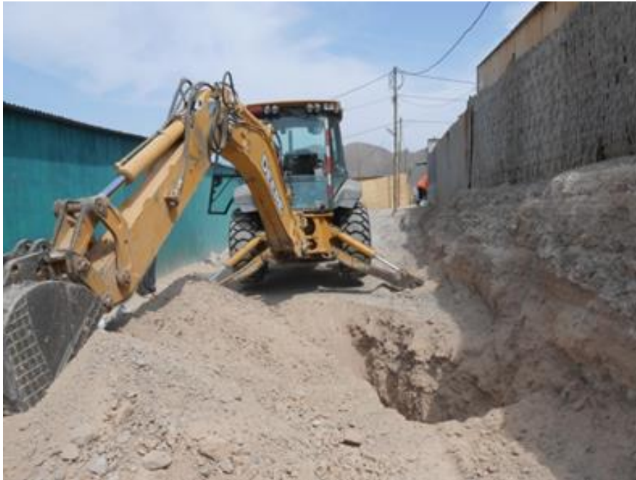
Fotografía 3: Apertura de calicata C-02
