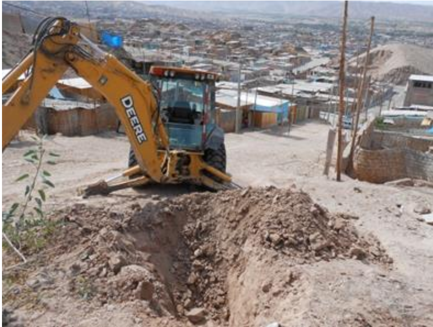
Fotografía 1: Inicio de apertura de la calicata C-01
