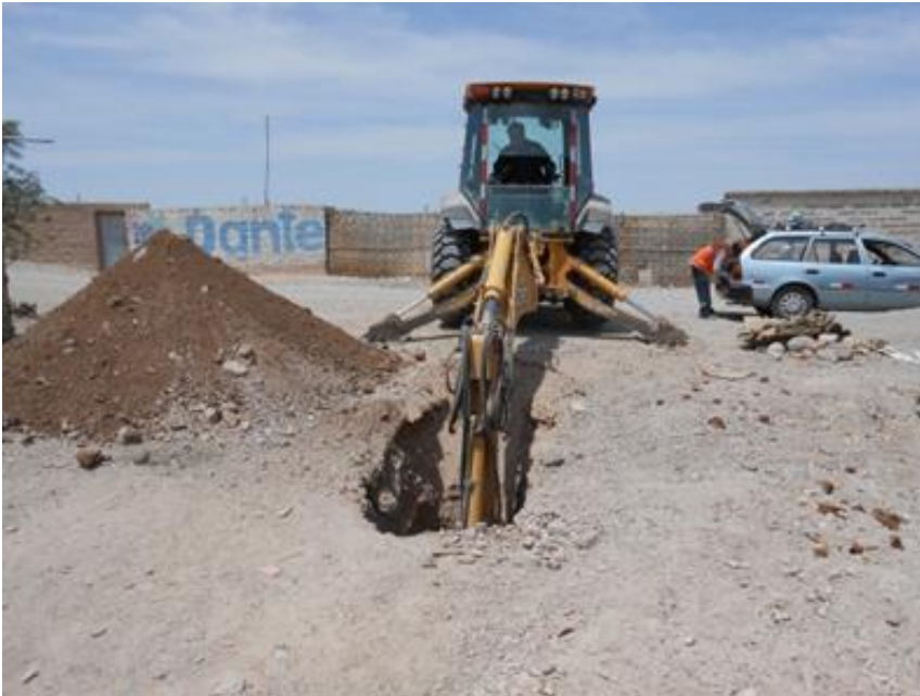
Fotografía 5: Apertura de calicata C-03
