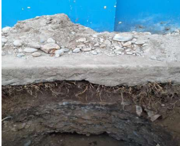
Figura 62. Zapata de concreto ciclópeo de la Institución Educativa “Jorge Basadre”
