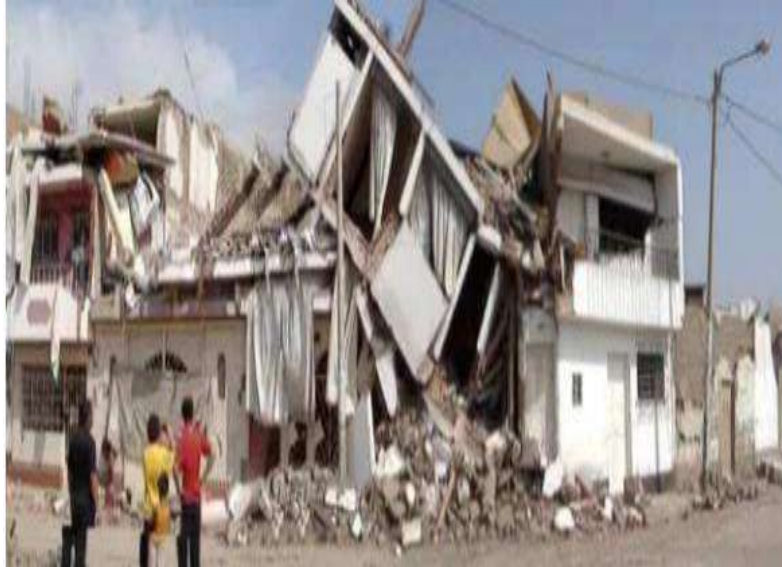
Figura 8. Vivienda colapsada en el sismo Pisco 2007 de magnitud de 7.9 Mw
