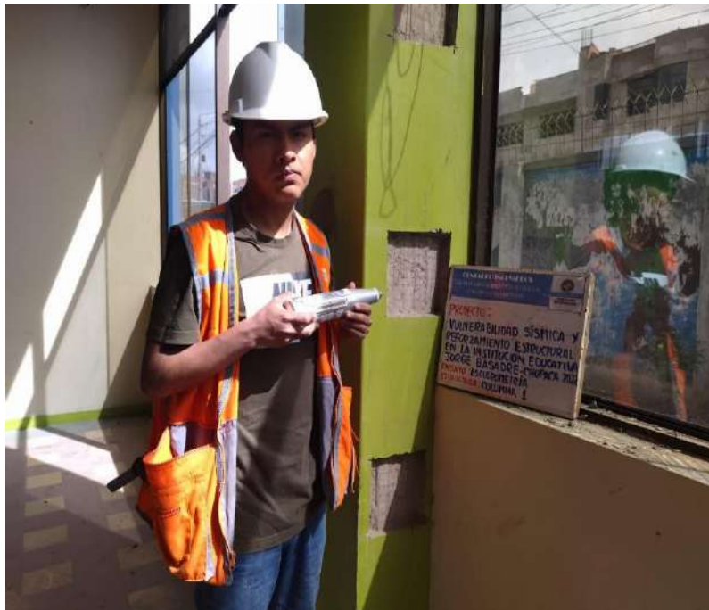
Figura 57. Ensayo de esclerometría - columna 1 (ASTM C 805).
