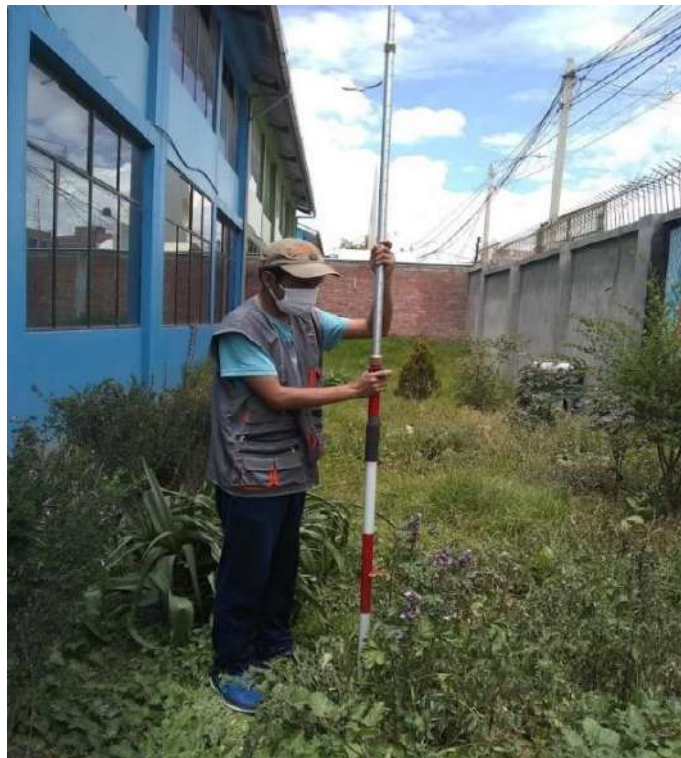
Figura 32. Recolección de puntos (coordenadas) - ubicación de las calicatas.
