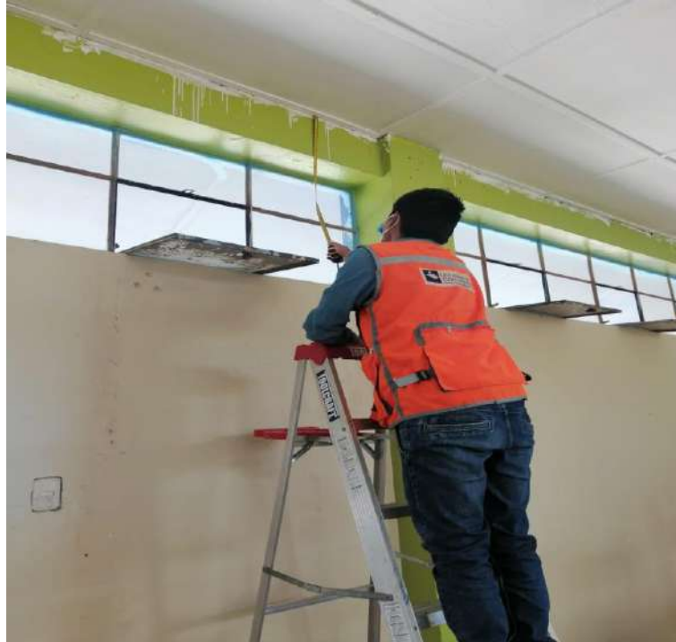
Figura 28. Medición del peralte de la viga de la Institución Educativa “Jorge Basadre”.
