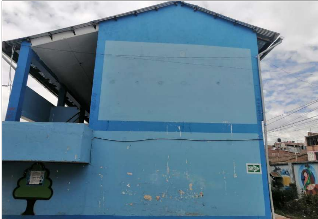
Figura 153. Pabellón A de la Institución Educativa Jorge Basadre – vista lateral
