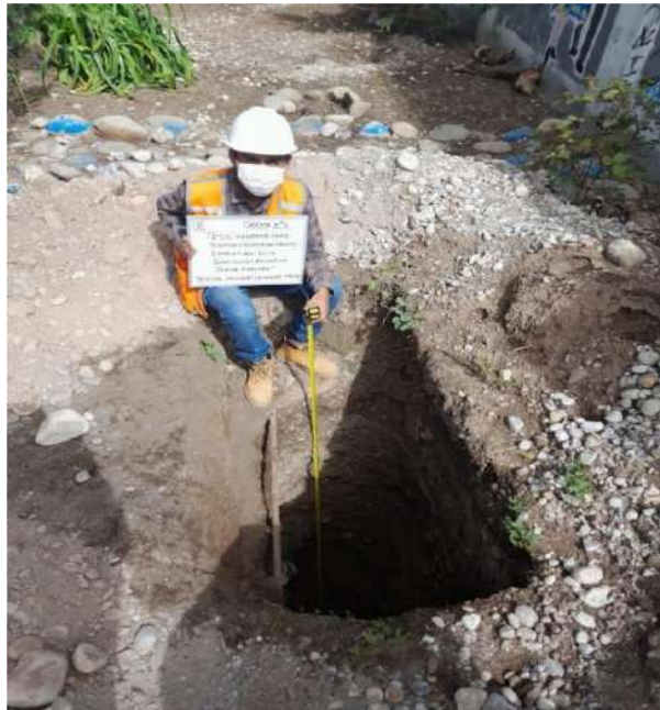
Figura 34. Extracción de la muestra - Calicata 3
