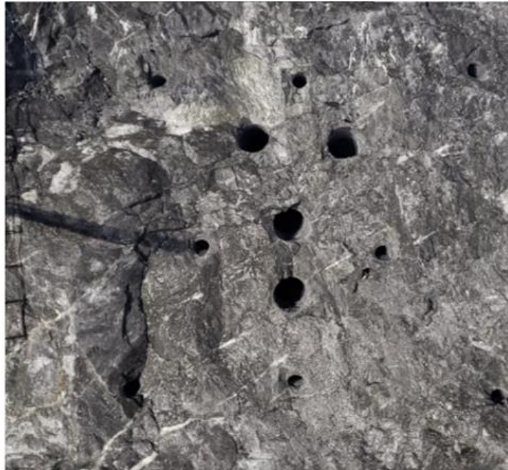
Figura 15. Exceso de burden en los arranques falta de simetría
