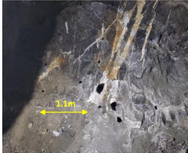
Figura 14. Frente fallado por desviación en perforación
