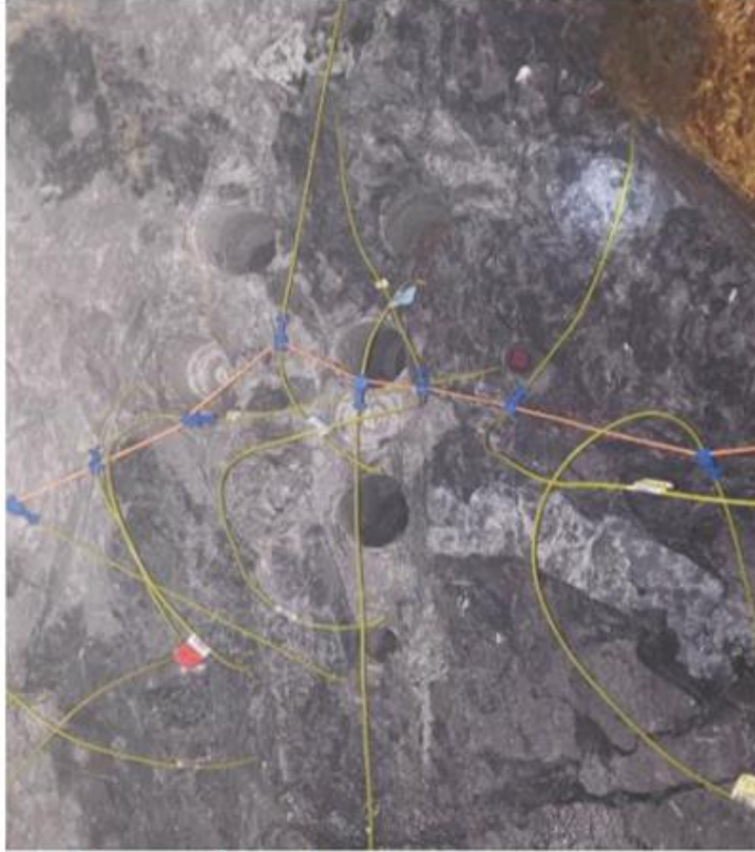
Figura 17. Carguío adecuado y amarre
