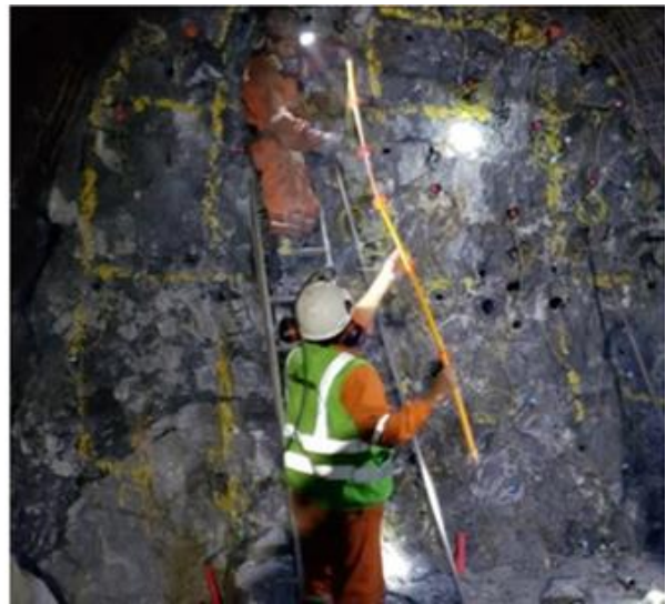
Figura 29. Carguío Famecorte E-20 SN 6917
