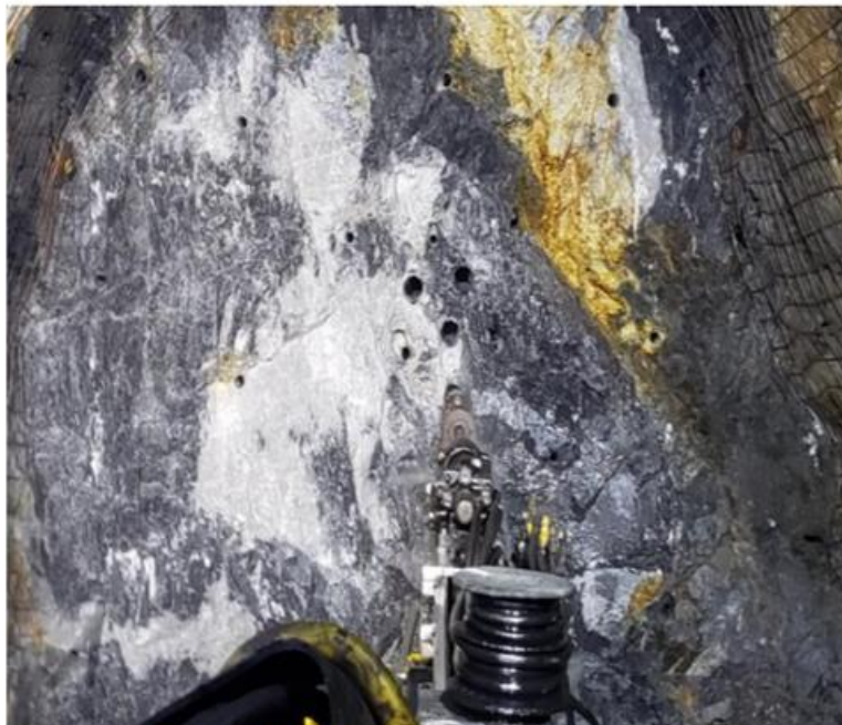
Figura 16. Simetría en la perforación de los taladros de arranque
