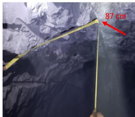
Figura 35. CX 1169 taladros cargados separados a 87 cm
