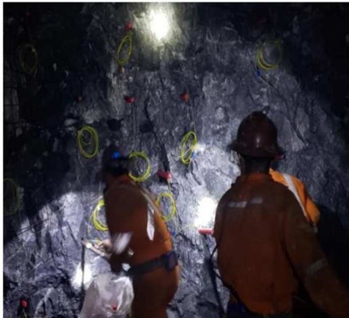
Figura 18. Control de carguío
