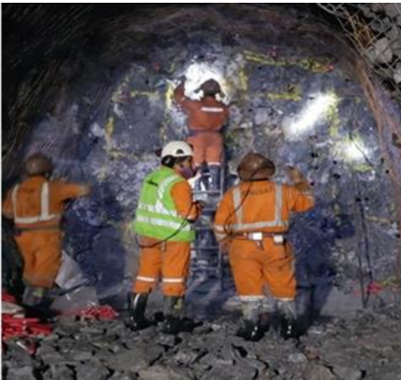
Figura 28. Carguío con capataz SN6917
