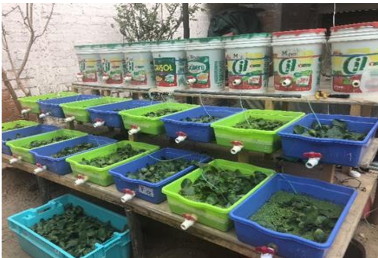
Figura 12. Sistema de humedales artificiales instalados y con sus respectivas plantas biorremediadoras. Elaboración propia.
