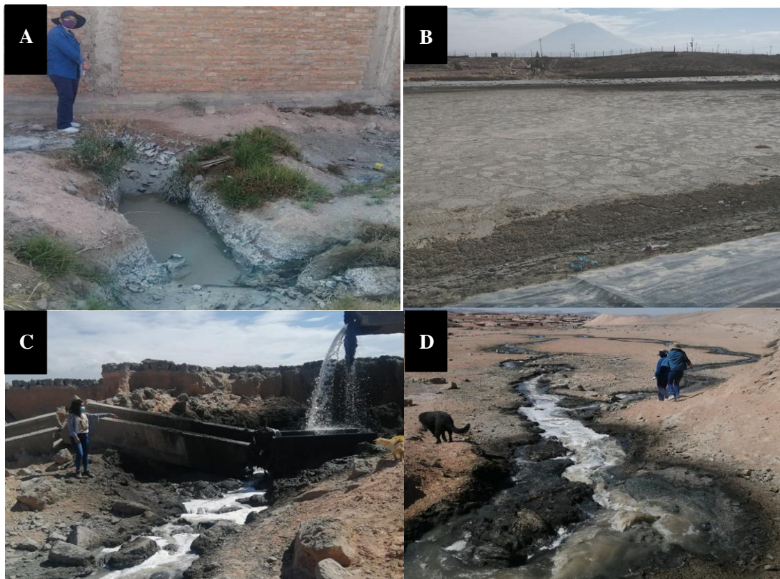
Figura 1. Escurrimiento de efluentes de curtiembre en PIRS. A) Aguas residuales aflorando de los registros fuera de la curtiembre; B) Pozas de oxidación colapsadas sin mantenimiento; C) Canal de conducción de efluentes de curtiembre del PIRS colapsado. D) Escurrimiento de los efluentes a través de Río Seco. Elaboración propia.
