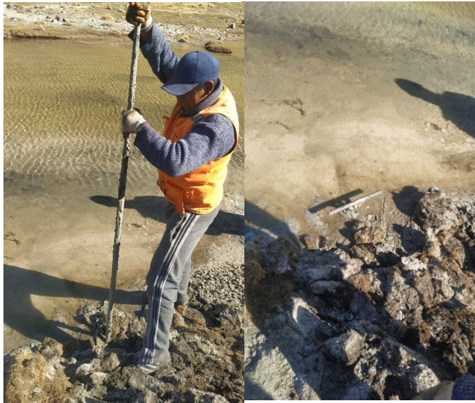
Figura N.º 7. Varillas de 5 m. Eje de presa (~ PP. 0+050)
