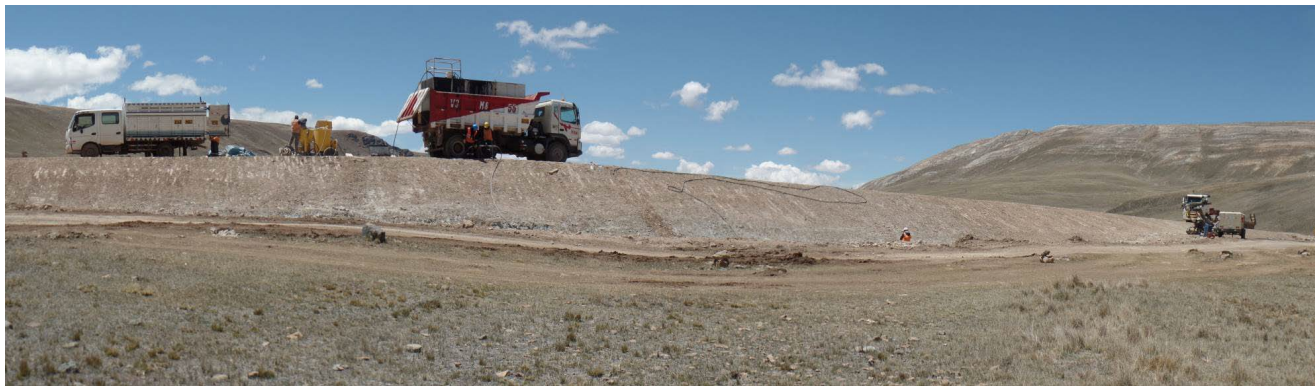
Fotografía N.º 4. Progresiva de 0+080 a 0+035. Perforación destructiva con truck drill, en horizontes de 0.00 a 3.40 metros aproximadamente se registraron horizontes de coberturas morrenicas y depósitos lagunares e infra yace la caliza.
