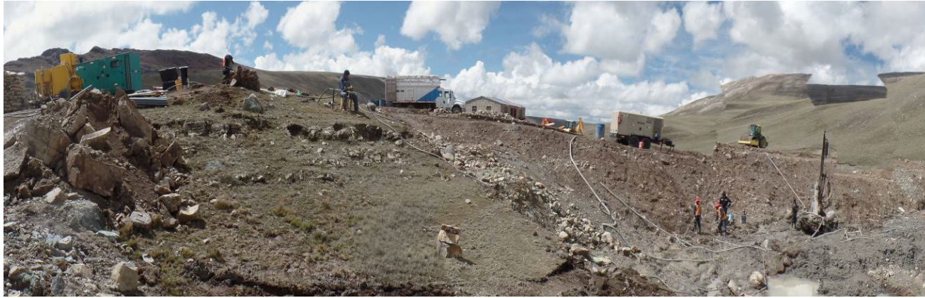
Fotografía N.º 3. Vista de la perforación en la Presa 1, progresiva de 0+110 a 0+080. Nótese la ubicación de la central de inyecciones. Este tramo en afloramiento de basamento rocoso es superficial hasta -1.50 m.
