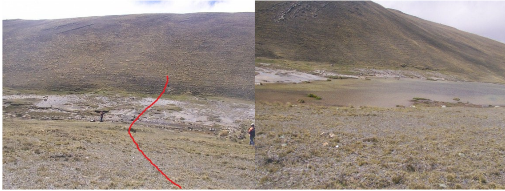
Fotografía N.º 15. Boquilla Presa 1.
