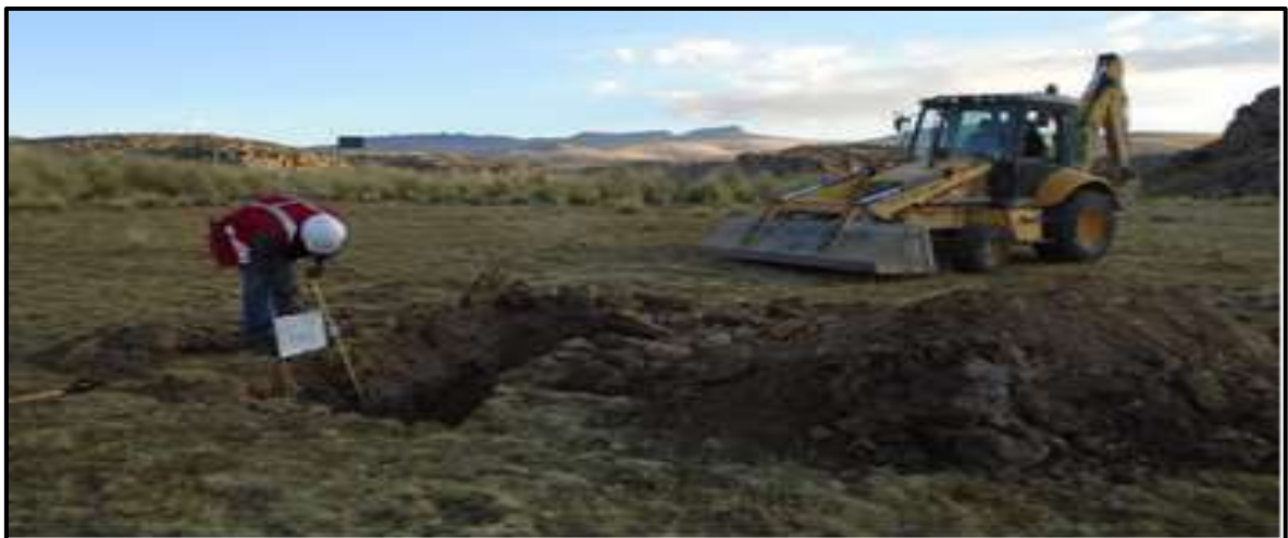
Figura 25. Excavación realizada en el margen derecho del vaso de presa.
