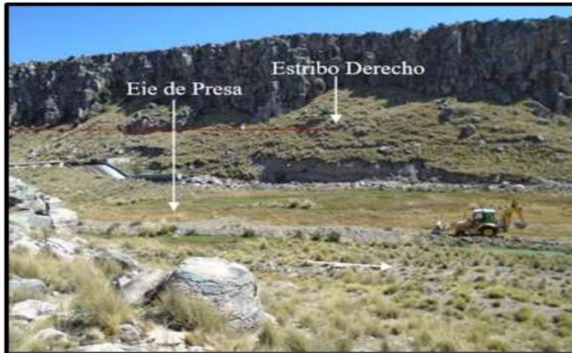
Figura 27. Vista panorámica de la Zona de Estudio. Fuente: Elaboración propia.
