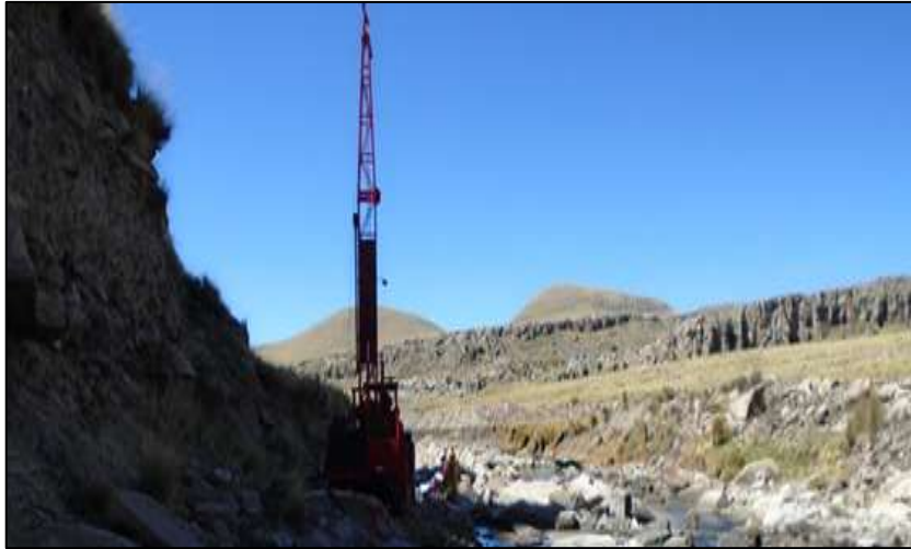
Figura 23. Sondaje diamantino en el eje de presa. Fuente: Elaboración propia.
