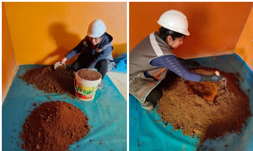
Figura 36. Mezcla de la tierra con el agua.
