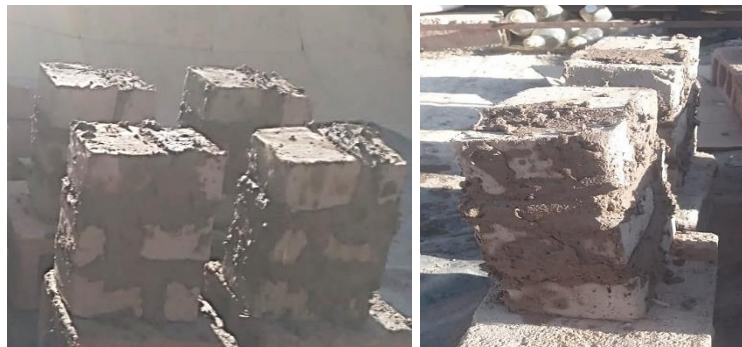
Figura 56. Asentado de muros de adobe.
