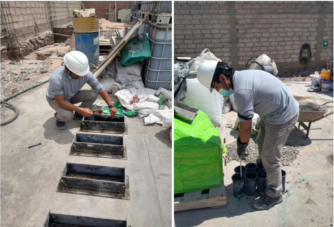
IMAGEN 4: PREPARACIÓN DE LOS MOLDES PARA EL VACIADO
