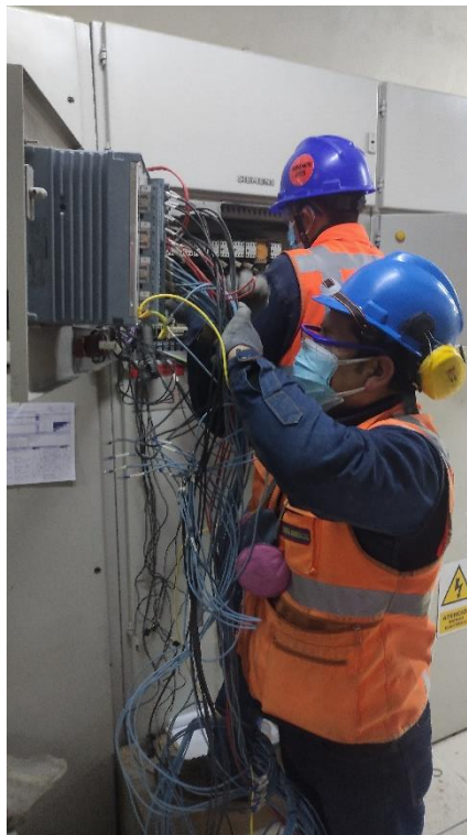
Figura 23. Desmontaje y desconexión de placas y accesorios
