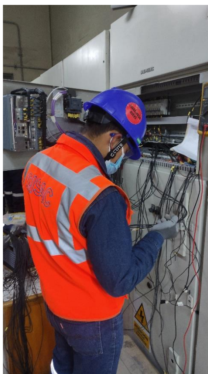
Figura 25. Conexionado de cables y control de placas
