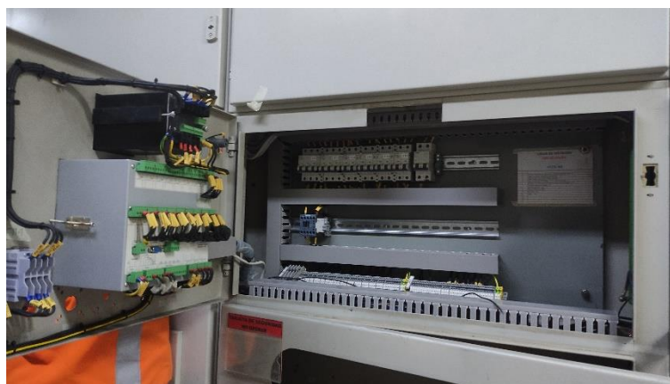
Figura 33. Cableado y conexionado de accesorios en la celda de medición
