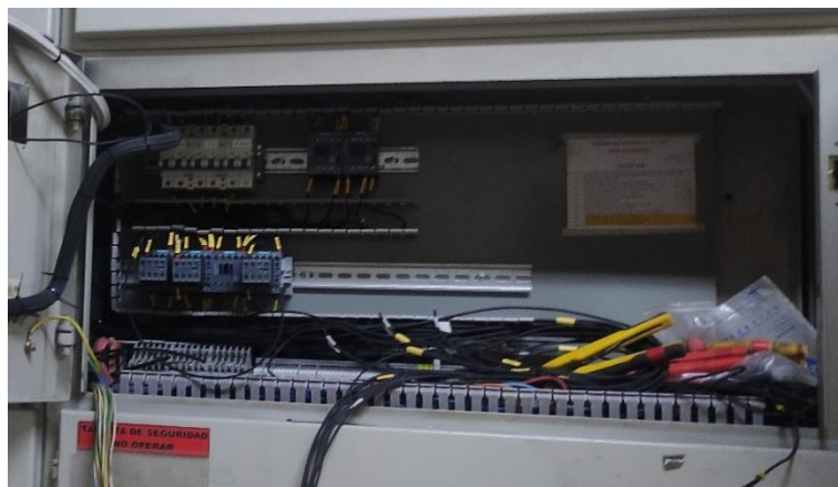
Figura 28. Desconectado y desmontaje de las placas existentes en la celda de MT
