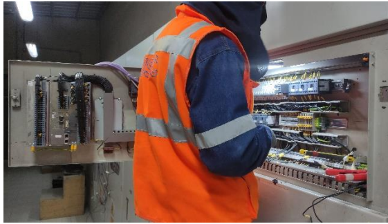
Figura 43. Modificación del circuito eléctrico de control en la celda de MT
