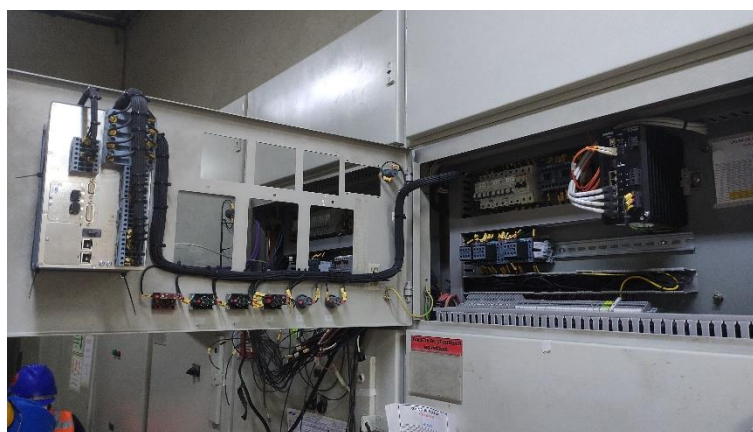
Figura 29. Cableado y conexasión de Smith y accesorios en la celda de MT
