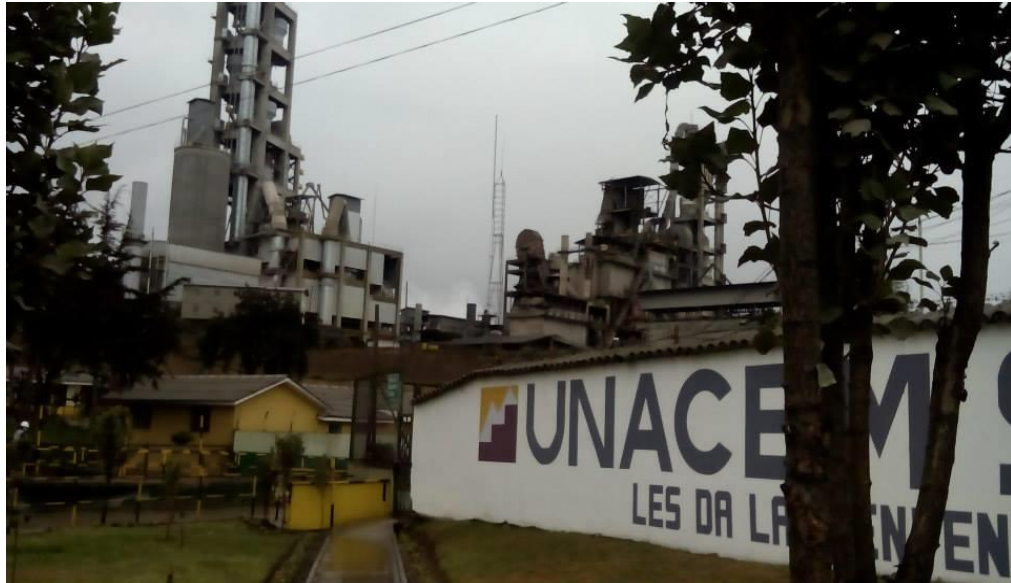
Figura 18. Planta cementera Unacem - Condorcocha
