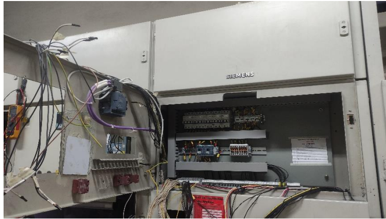
Figura 41. Montaje de la placa nueva de la ventiladora de tiro
