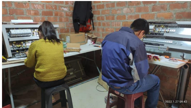
Figura 46. Montaje de aparamenta y cableado de placas en taller
