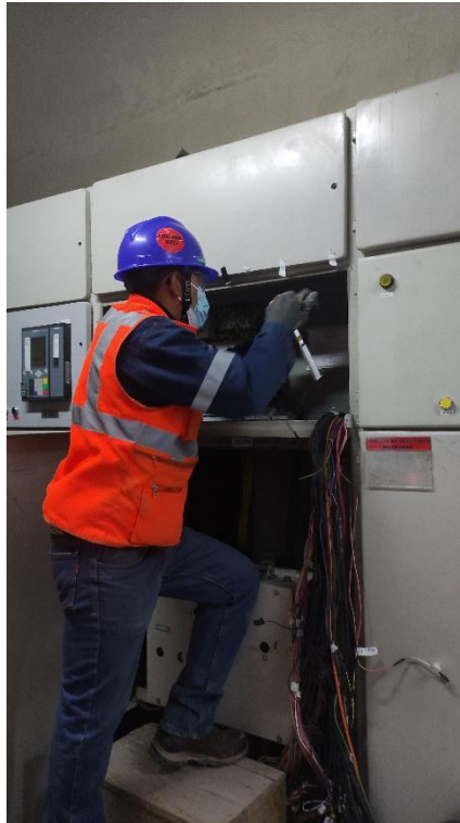
Figura 20. Montaje de placa y adecuación de la puerta
