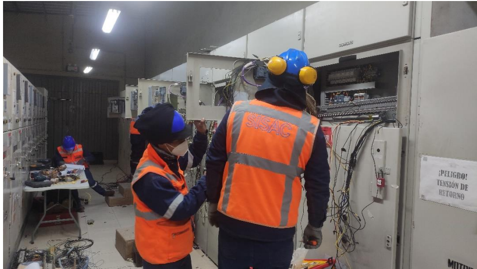
Figura 49. Cambio de placas habilitadas previamente
