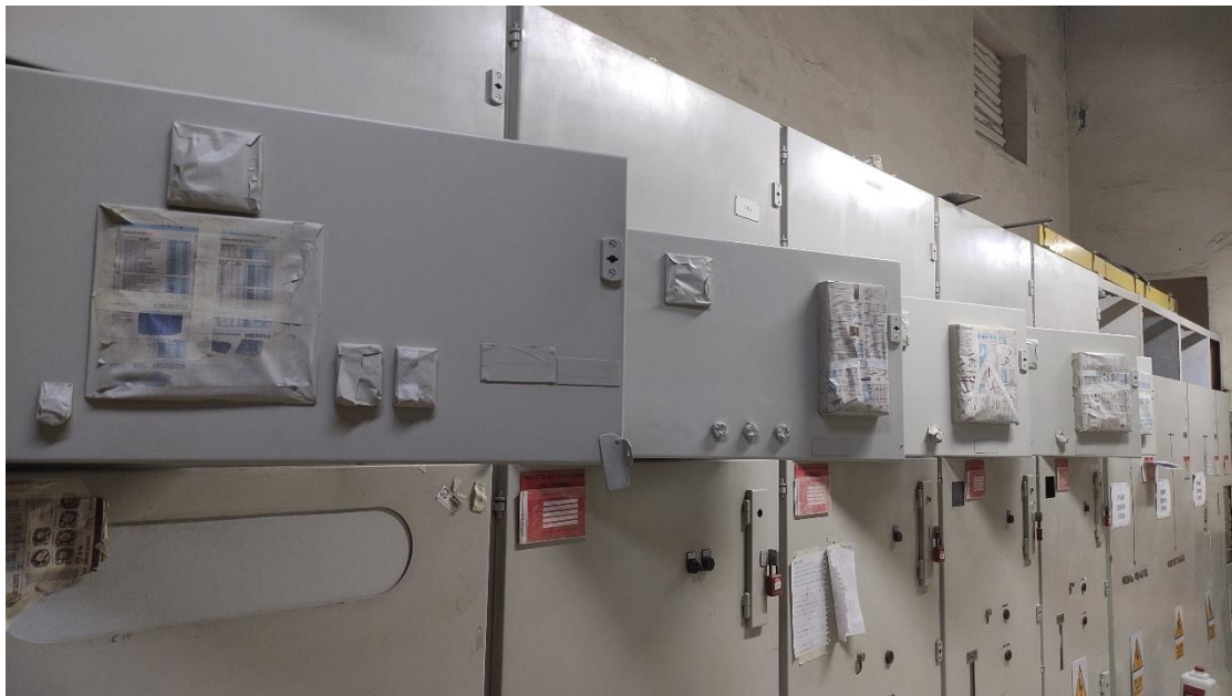
Figura 50. Resanado y pintado de celdas intervenidas
