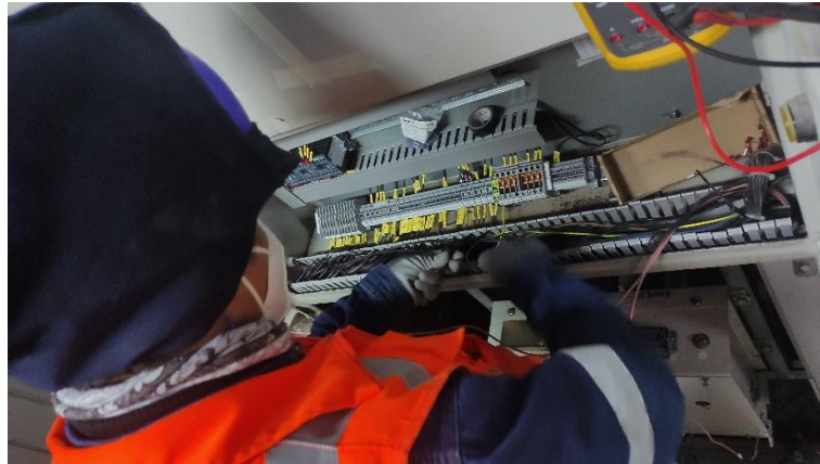
Figura 21. Tagueado y peinado de conductores en la celda de media tensión
