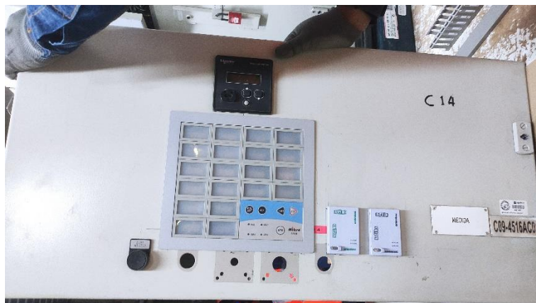
Figura 32. Montaje de medidor nuevo y accesorios de resanado
