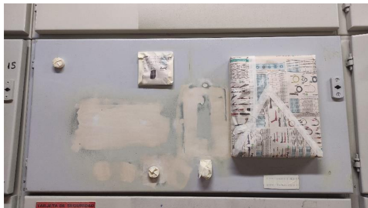
Figura 37. Montaje de placa y resanado de puerta de la trituradora TANDEN
