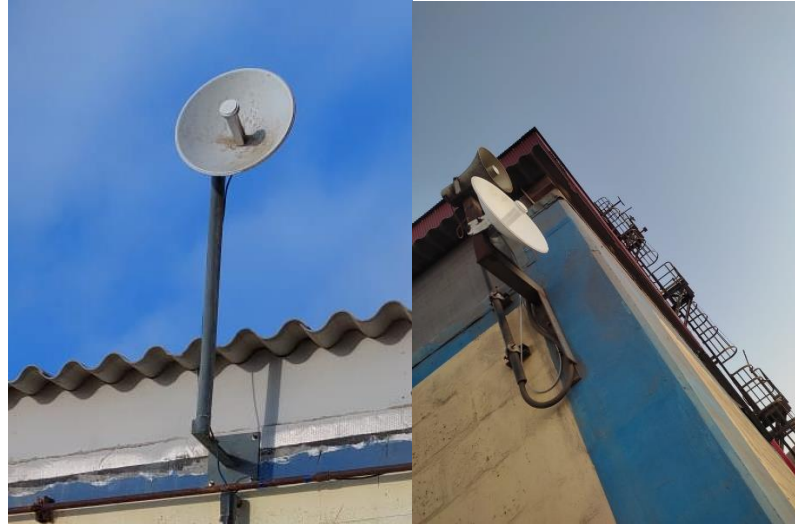
Figura 72. Montaje de antena en 570-sala electrica y en 510-sala de control
