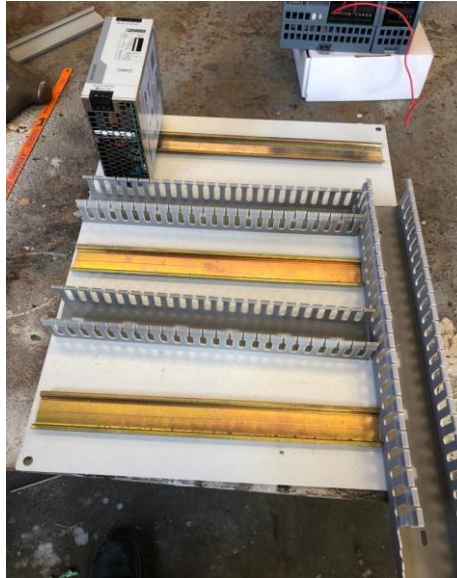
Figura 55. Montaje de componentes del tablero eléctrico de control (2)
