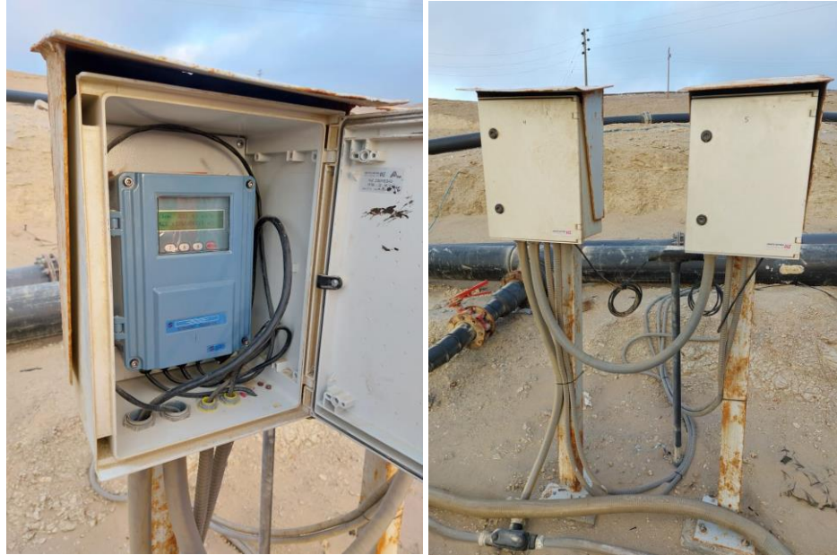
Figura 60. Canalización de circuitos en tablero de flujómetros (8)
