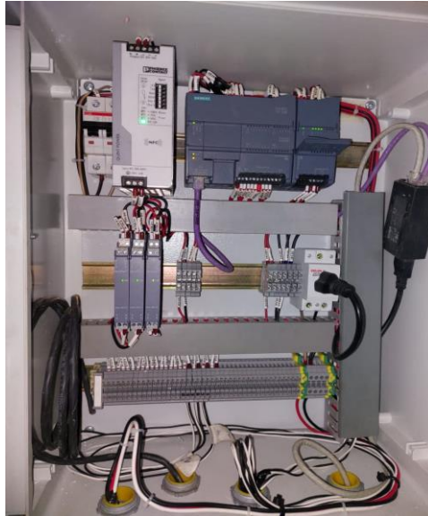
Figura 58. Montaje de tablero de forma empotrada (2)
