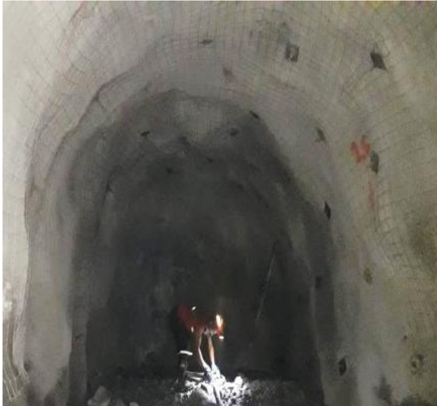
Figura 9. Sostenimiento con shotcrete de sacrificio de toda la galería principal 9080-SW
