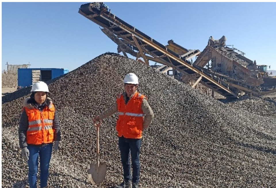
Fotografía 1. Extracción de piedra chancada para el diseño de mezcla del concreto
