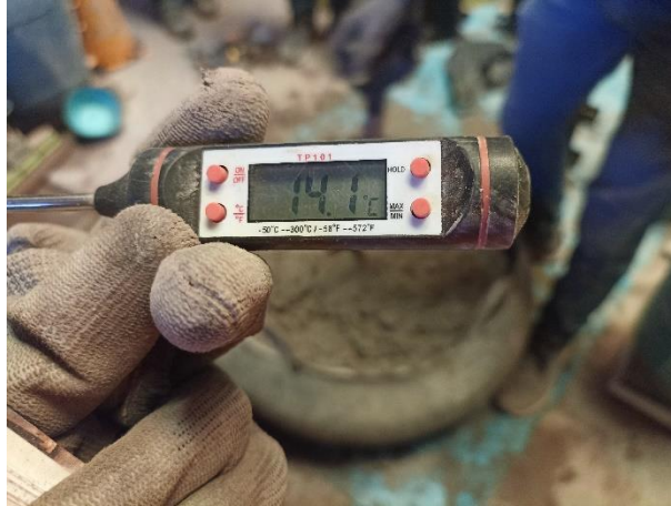
Figura 28. Ensayo de temperatura del concreto.
