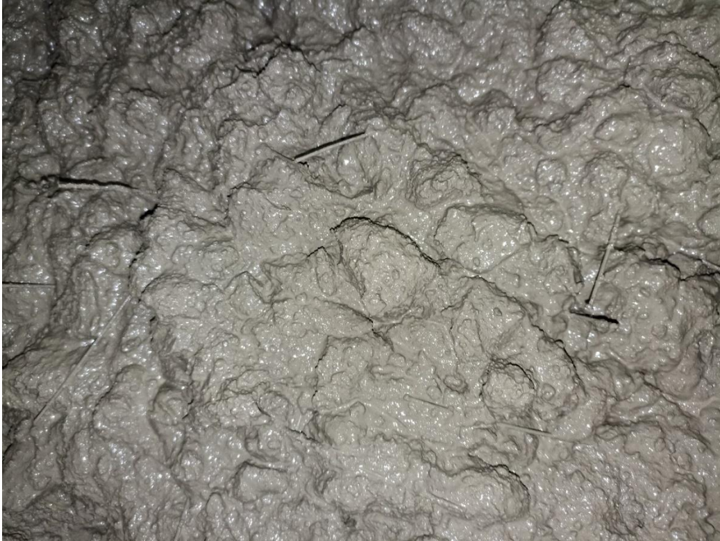
Fotografía 11. Concreto con fibras de acero reciclado
