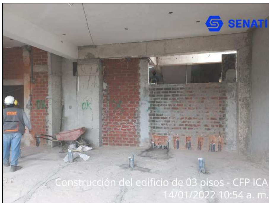
Figura 72. Verificación de muros y tabiques
