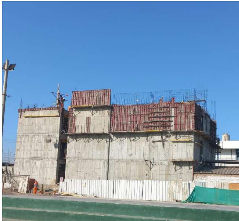
Figura 13. Proceso de ejecución de casco estructural Tomada de Informes mensuales
