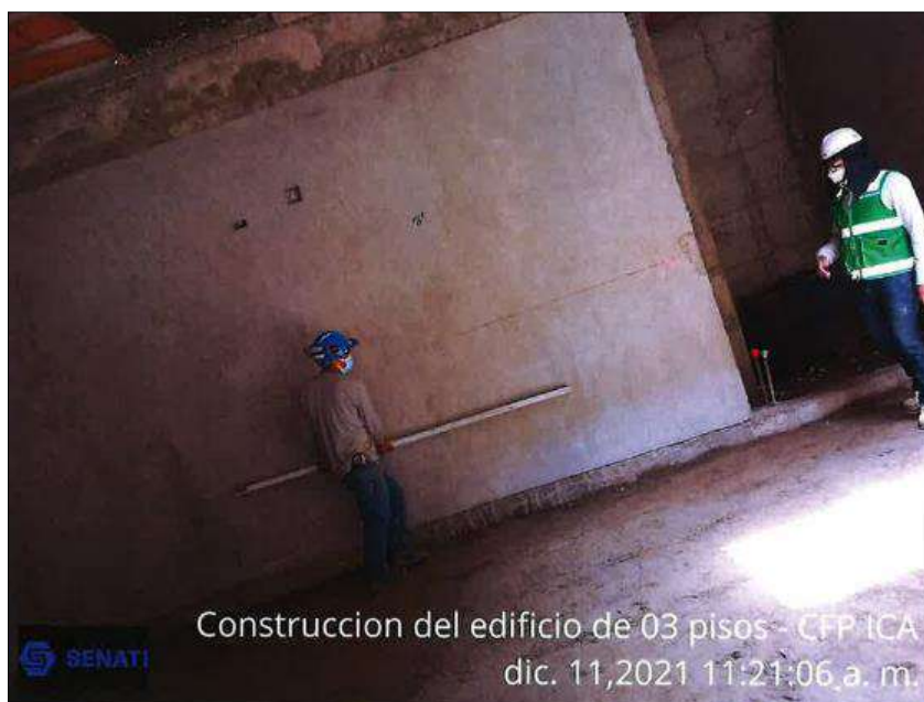
Figura 73. Verificación de tarrajes y revoques
