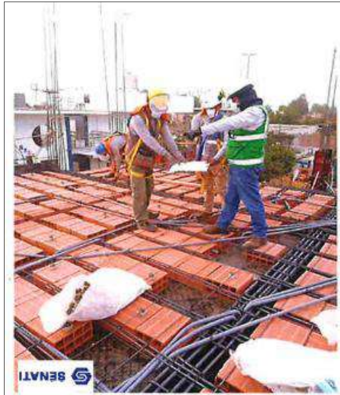
Figura 70. Verificación de vigas
