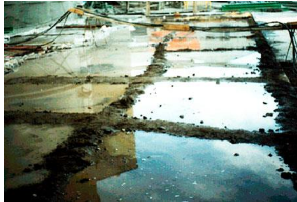
Figura 6. Curado del concreto empleando la técnica de inmersión Tomada de Google Imágenes
