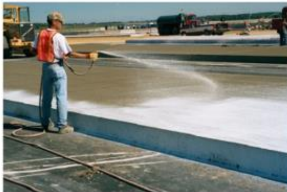
Figura 1. Técnicas de curado exterior del concreto Tomada de Google Maps (2021)
