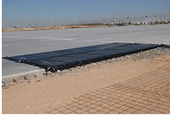
Figura 8. Curado del concreto empleando la técnica de cubrir con material absorbente
