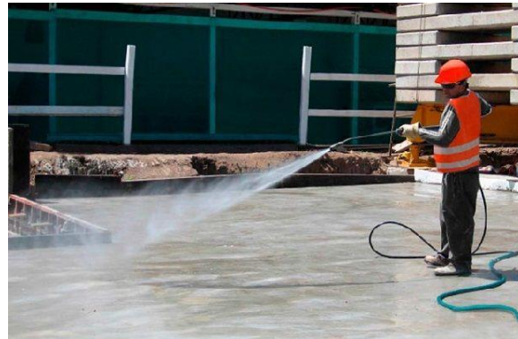
Figura 7. Curado del concreto, empleando la técnica de riego Tomada de Google Imágenes
