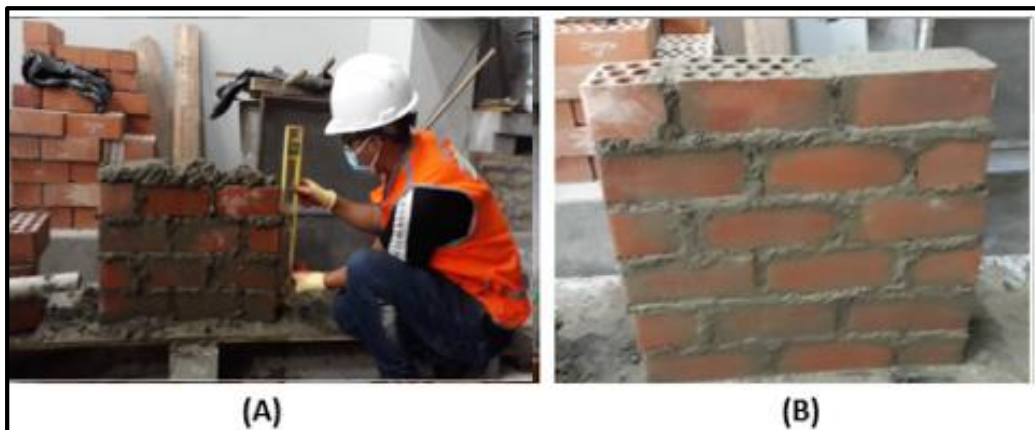
Figura 4.12. (A) Elaboración del murete con nivel de mano; (B) Refrenado realizado en las esquinas del murete.
