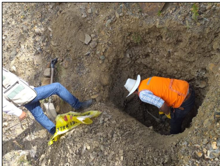
Calicata N°1 realizado en el área de estudio
