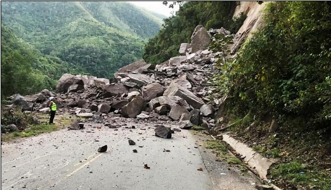
Figura 3 Desprendimiento de roca
