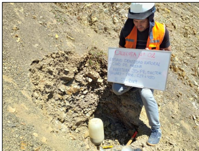
Ensayo de cono de arena realizado en la calicata N°2
