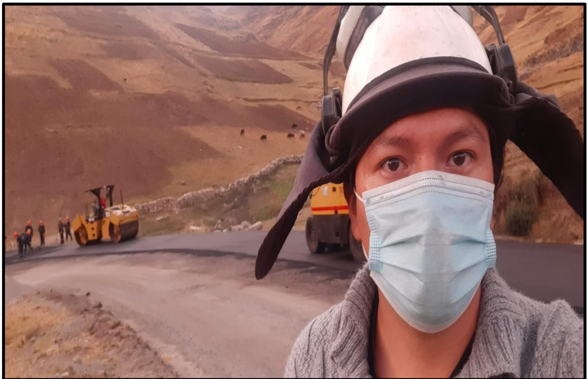
Foto 20: Compactación con rodillo neumático y rodillo Tandem de la carpeta asfáltica
