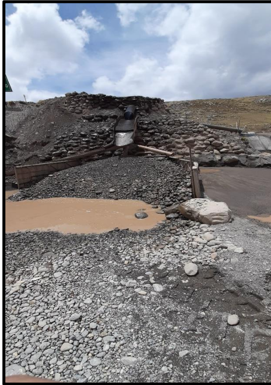
Foto 03: Lavado de material para obtener arena zarandeada
