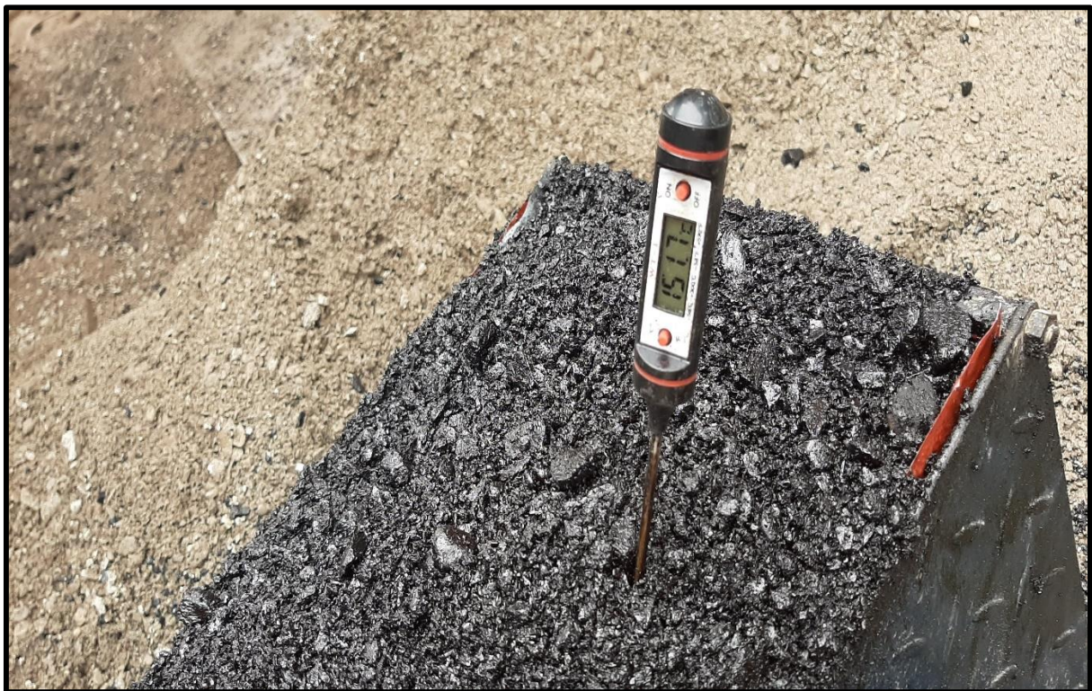
Foto 12: Control de temperatura de la mezcla bituminosa
