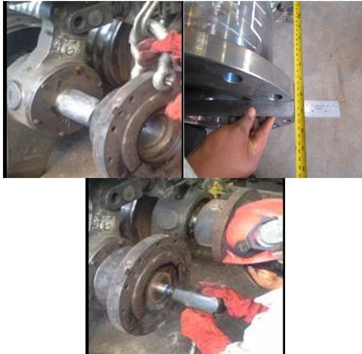
Figura 46. Calentamiento de bridas
