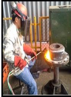
Figura 44. Montaje de bridas
