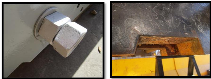
Figura 32. Inspección y calibración de puentes
