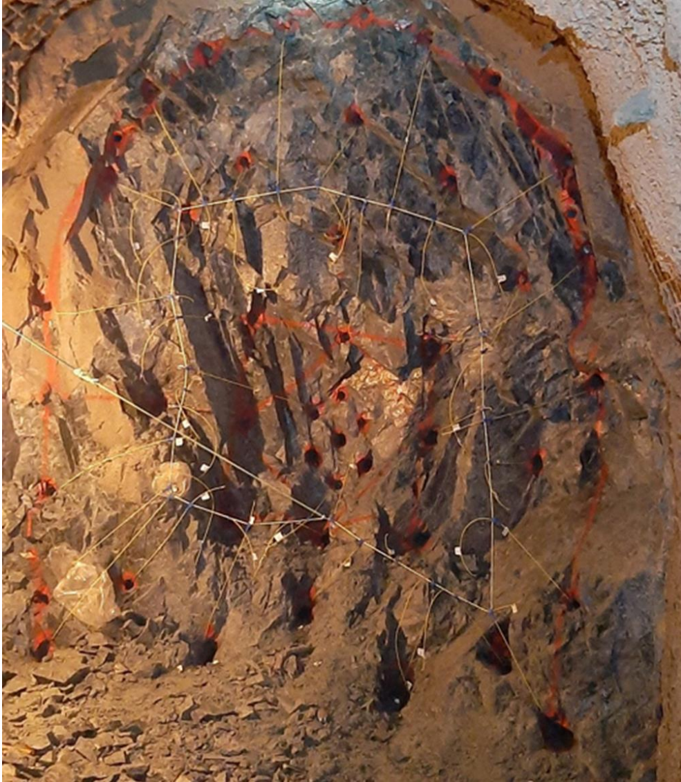
Figura 16. Escenario óptimo - carguío del diseño de malla de perforación y voladura con sección 2.4 x 2.4 metros con longitud de barra de 8 pies de la galería principal de la zona Ancasillo - veta Julia Tomada del departamento de Operaciones de la minera Apmnac Pulpera
